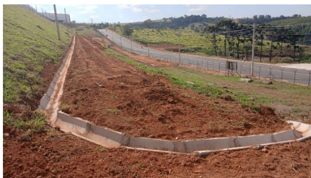
Instalação do sistema de drenagem no talude.
