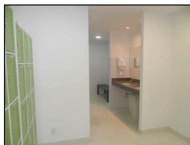
Conjunto de sanitários - Unidade 318
