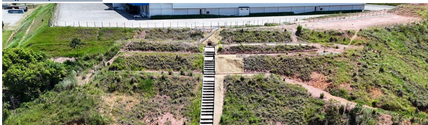
Imagem 6: Reparos no Talude
