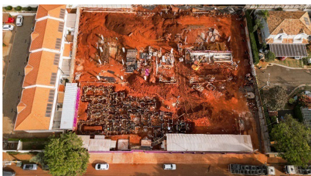
Imagem Aérea – Visão Geral (mai/25) – Pilares Bloco Garagem e fundação Torre Residencial em execução.
