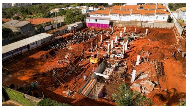
Imagem Aérea – Visão Geral (mai/25) – Pilares Bloco Garagem e fundação Torre Residencial em execução.
