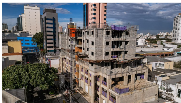
Imagem Aérea – Visão Geral (jun/25) – Lado A alvenaria estrutural 7º pavimento e Lado B laje do 8º pavimento.
