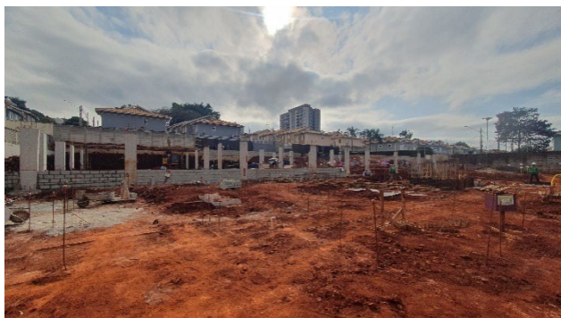
Torre Residencial – Blocos de fundação concluídos e ao fundo Bloco Garagem.
