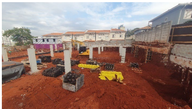
Bloco Garagem – Pilares de apoio da laje.
