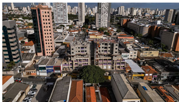
Imagem Aérea – Visão Geral (jun/25) – Lado A alvenaria estrutural 7º pavimento e Lado B laje do 8º pavimento.
