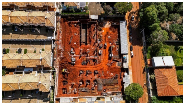
Imagem Aérea – Visão Geral (abr/25) – Pilares Bloco Garagem e fundação Torre Residencial em execução.
