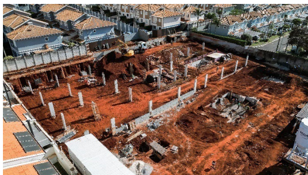
Imagem Aérea – Visão Geral (jun/25) – Preparação para laje e alvenaria perimetral do Bloco Garagem e conclusão de fundação da Torre Residencial.
