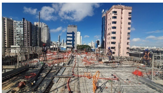
Torre Lado B – Armação laje 8º pavimento.
