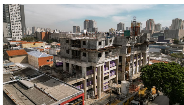
Imagem Aérea – Visão Geral (mai/25) – Lado A e Lado B laje do 6º pavimento.
