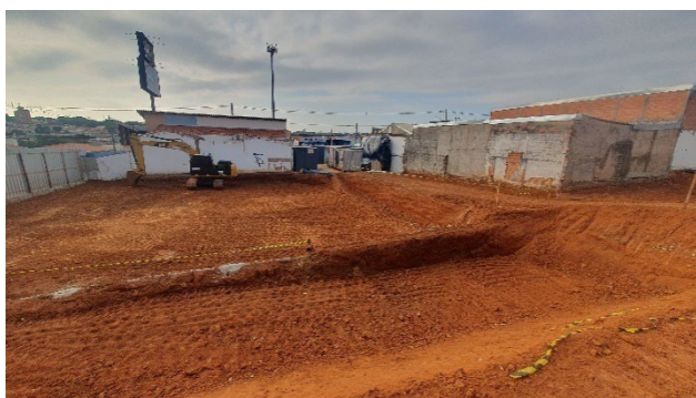
Terraplenagem terreno e gabarito de marcação de obra.
