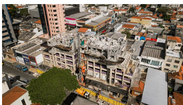
Imagem Aérea – Visão Geral (abr/25) – Lado A alvenaria estrutural do 4º pavimento e Lado B laje do 5º pavimento.
