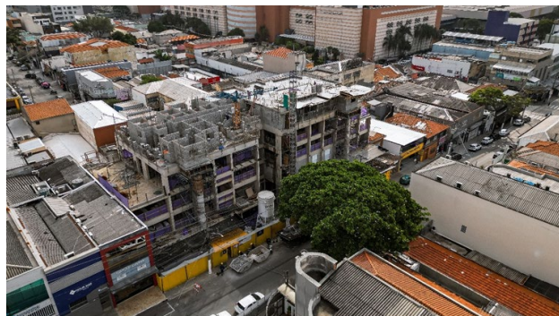
Imagem Aérea – Visão Geral (abr/25) – Lado A alvenaria estrutural do 4º pavimento e Lado B laje do 5º pavimento.
