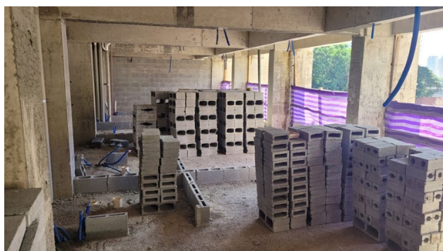
Torre – Alvenaria vedação 3º pavimento.
