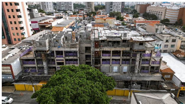
Imagem Aérea – Visão Geral (abr/25) – Lado A alvenaria estrutural do 4º pavimento e Lado B laje do 5º pavimento.
