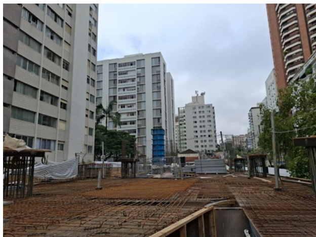
Estrutura laje 1º Pavimento.
