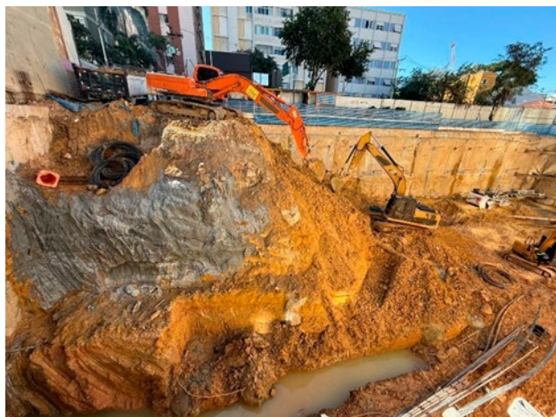
Escavação e Tirantes – Nível 4º Subsolo.
