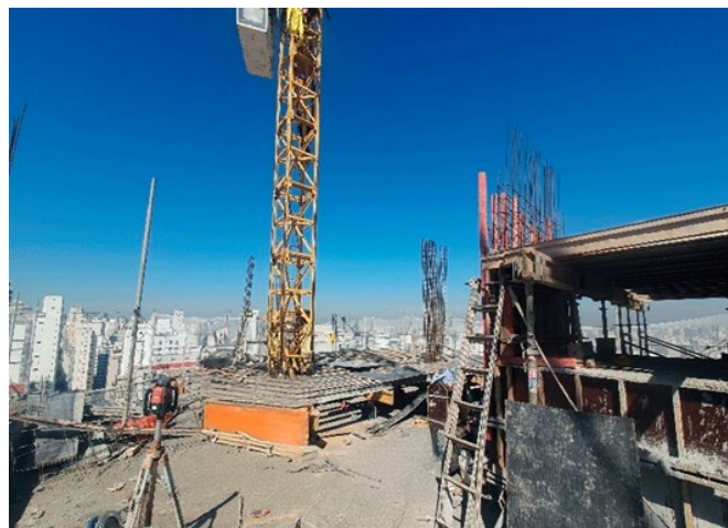
Estrutura nível Atico.
