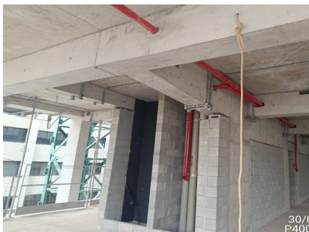
2º Pavimento – Instalações.
