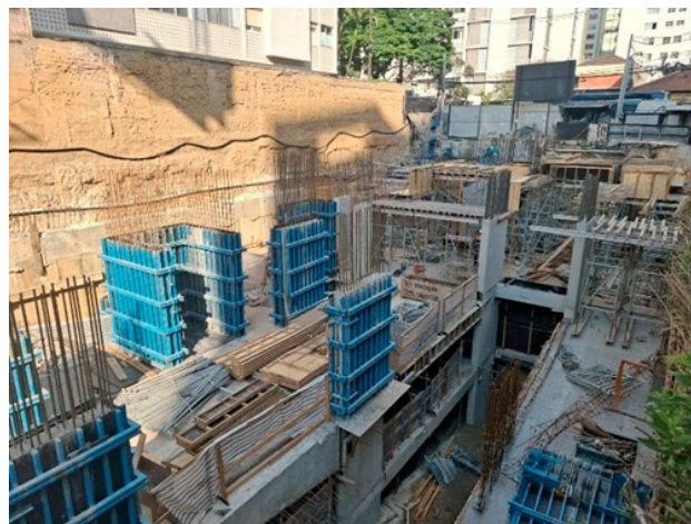
Estrutura 1º Subsolo.
