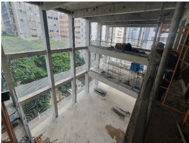
4º, 5º e 6º Pavimentos – Conjunto Corporativo Triplex.
