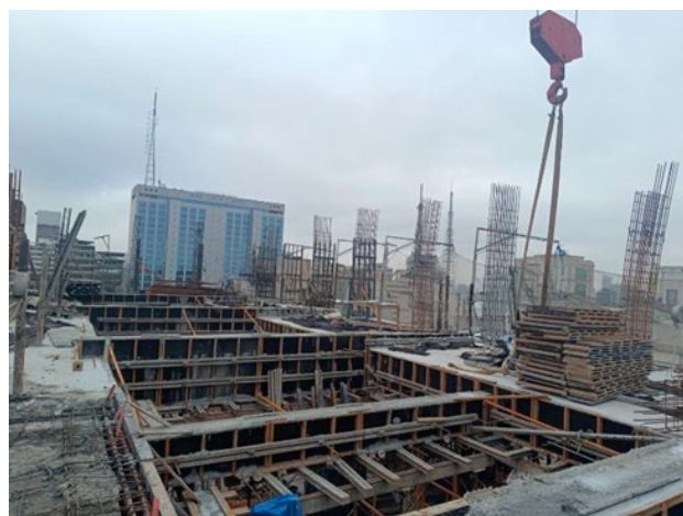
Estrutura laje 17º Pavimento.
