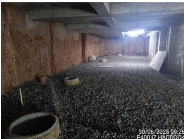
5º Subsolo – Preparação do Piso.
