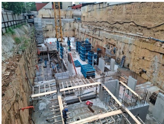
Estrutura 2º Subsolo.
