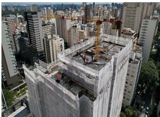
Estrutura 16º Pavimento.
