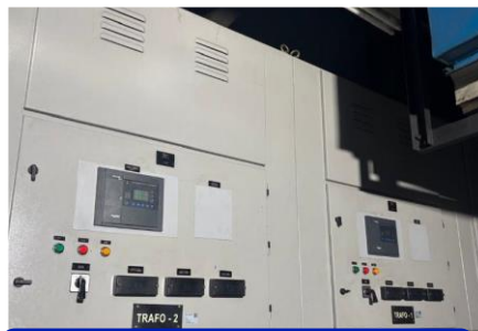
Finalização da revisão de quadros e controle de entrada de energia
