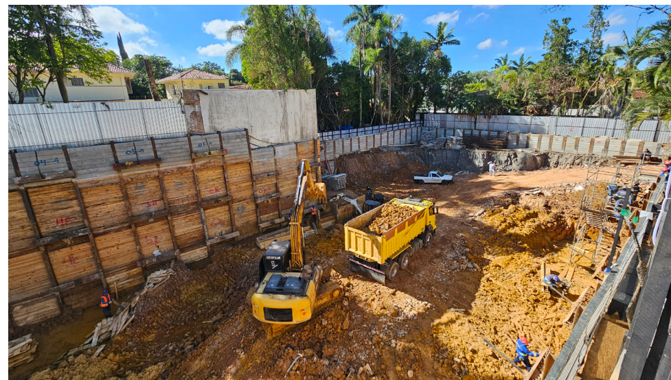
FOTO DA OBRA
