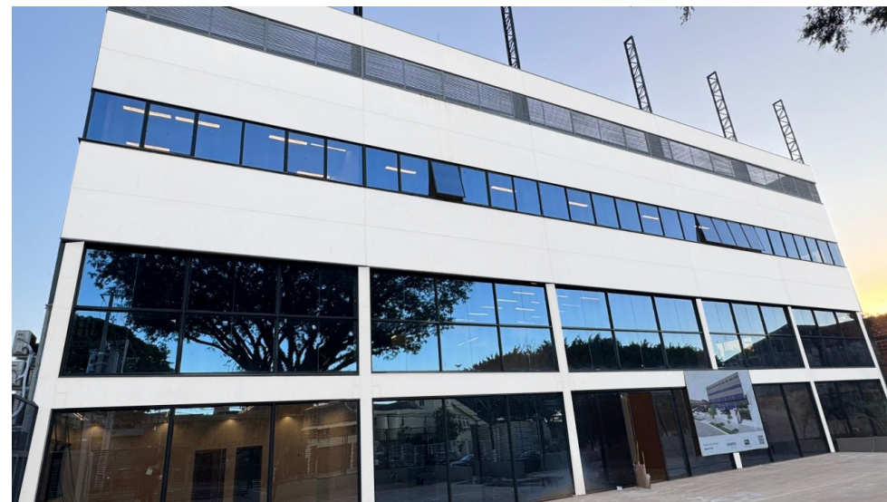
FOTO DA OBRA
