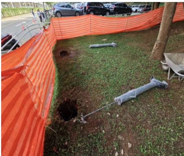
Execução de suportes de tubulação
