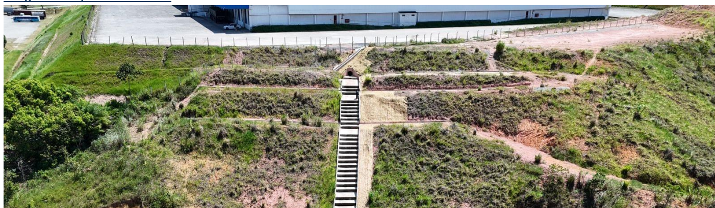
Imagem 6: Reparos no Talude
