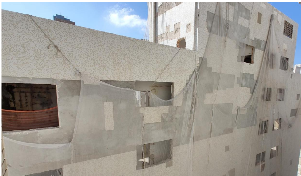
Reparos na fachada
