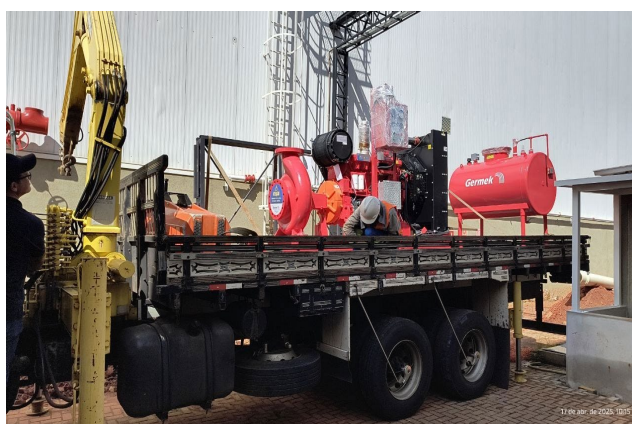
Interligação dos reservatórios com a nova tubulação às bombas existentes e pressurização da rede e entrega da nova bomba.
