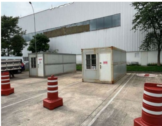
Implantação de canteiro.
