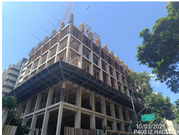
Vista fachada – Esquina Rua Haddock Lobo x Rua Antonio Carlos.
