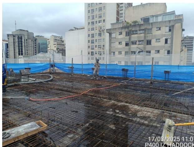
Armação laje – 8º Pavimento.
