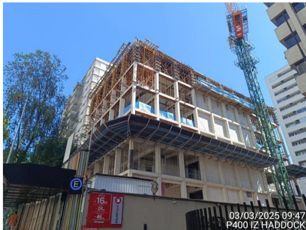
Vista fachada – lado vizinho na Rua Antonio Carlos.
