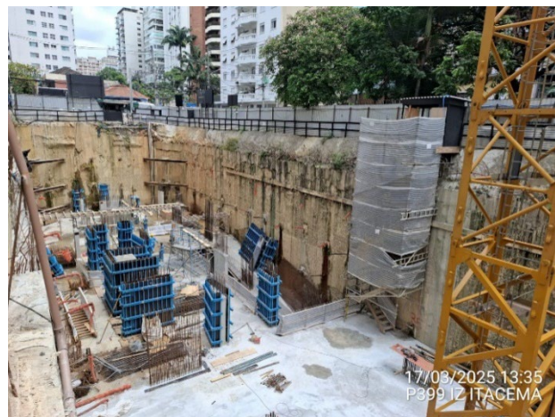
Armação e forma pilares – 2º Subsolo (Etapa 1).
