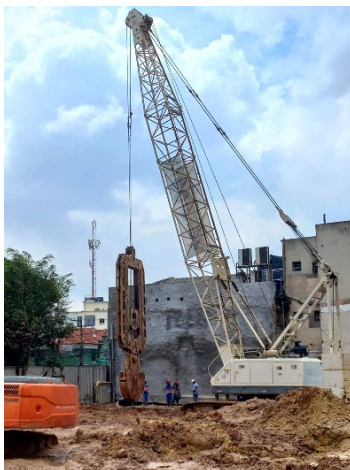
Parede Diafragma – Retomada após reforço vizinho.
