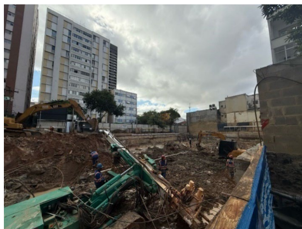
Escavação e execução de tirantes – 1º Subsolo.
