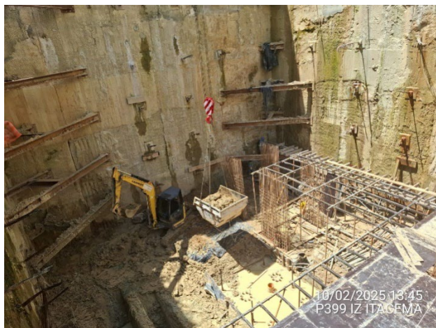
Remoção de solo de escavação – 5º Subsolo.
