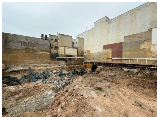
Arrasamento estacas – 1º Subsolo.
