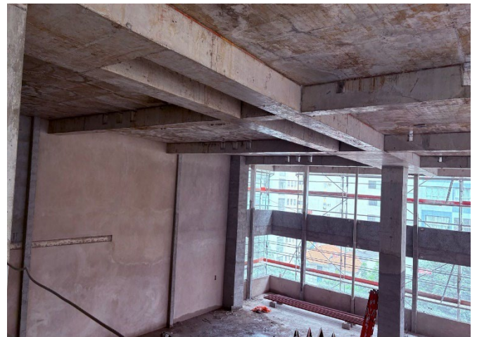
Emboço alvenaria – 2º/3º Pavimento.
