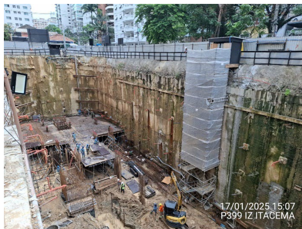
Armação pilares e cimbramento – 4º Subsolo.
