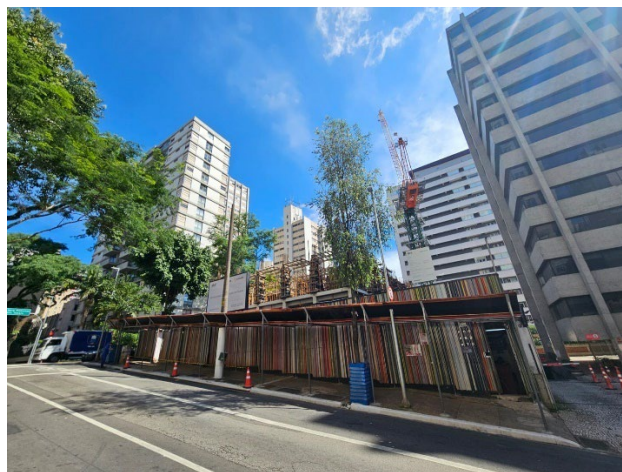
Vista fachada – Rua Antonio Carlos.
