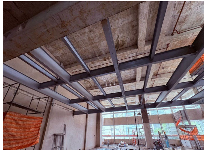
Estrutura metálica mezanino – 2º/3º Pavimento.
