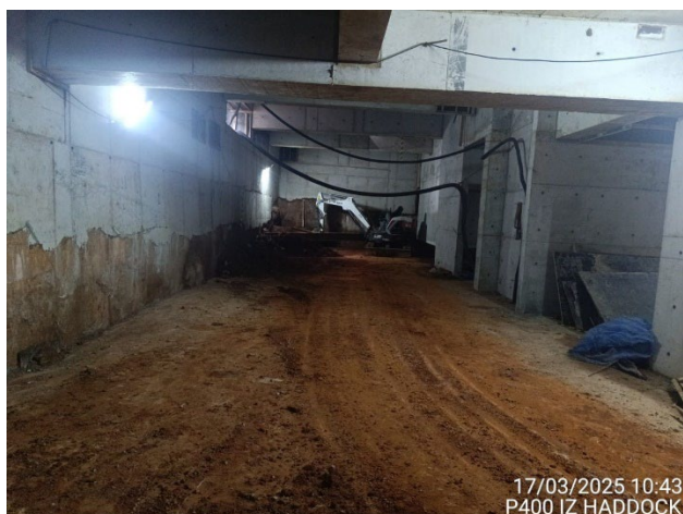
Nivelamento piso – 5º Subsolo.
