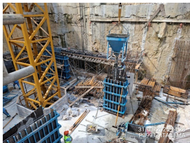
Concretagem pilares – 2º Subsolo (Etapa 2).
