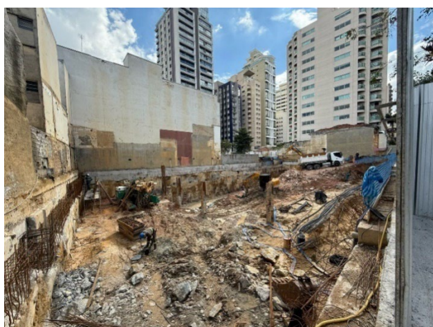
Visão geral – armação de viga de coroamento, escavação e execução de tirantes – 1º Subsolo.
