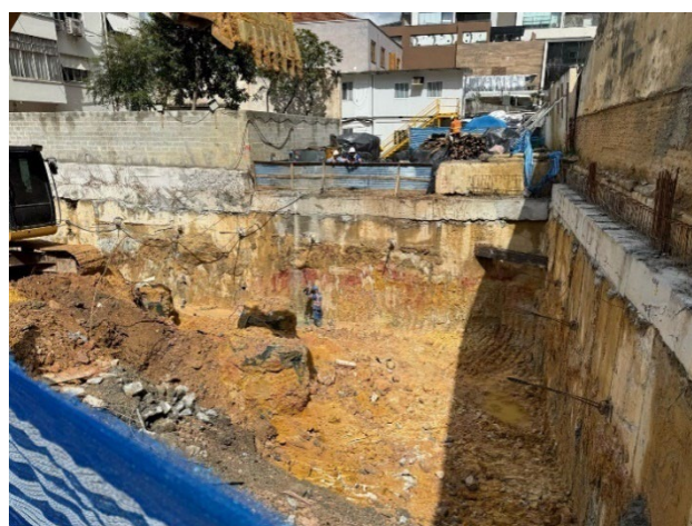
Escavação – 2º Subsolo.
