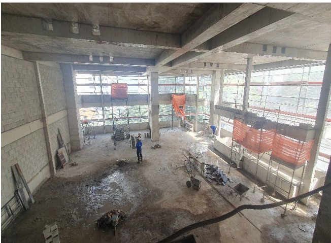
Estrutura e alvenaria – 2º/3º Pavimento.
