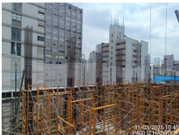
Armação e forma estrutura – 10º Pavimento.
