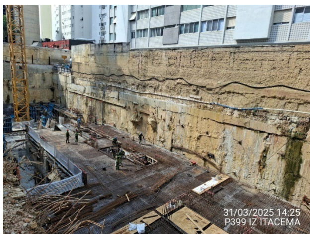
Armação laje – 2º Subsolo (Etapa 1).
