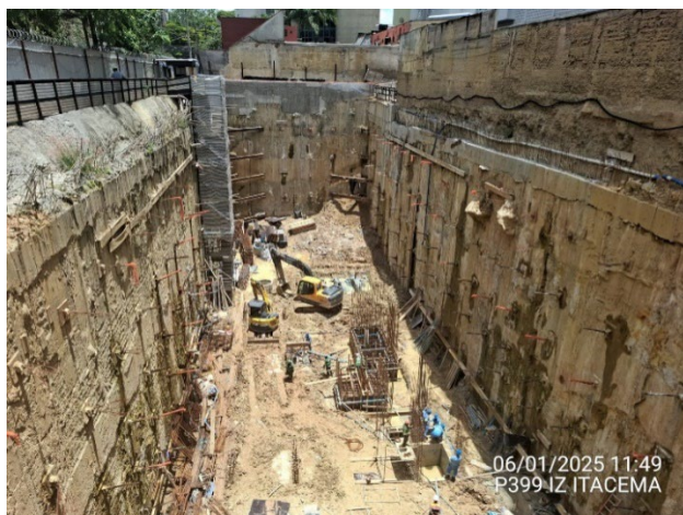
Escavação, blocos e início de armação de pilares – 4º/5º Subsolo.
