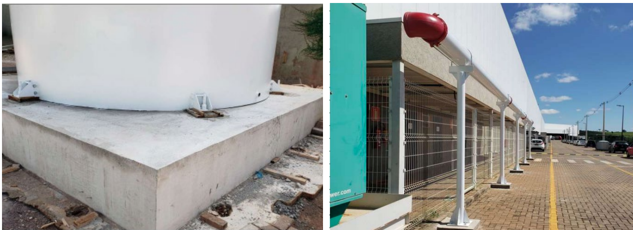
Instalação do reservatório e tubulação principal de abastecimento do sistema de combate a incêndio.
