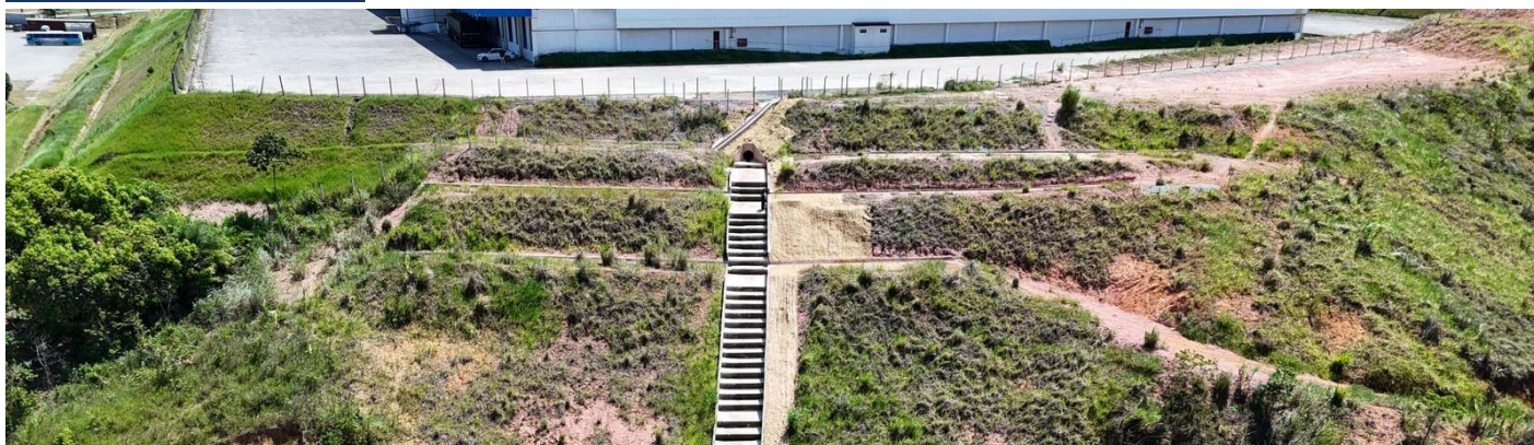
Imagem 6: Reparos no Talude
