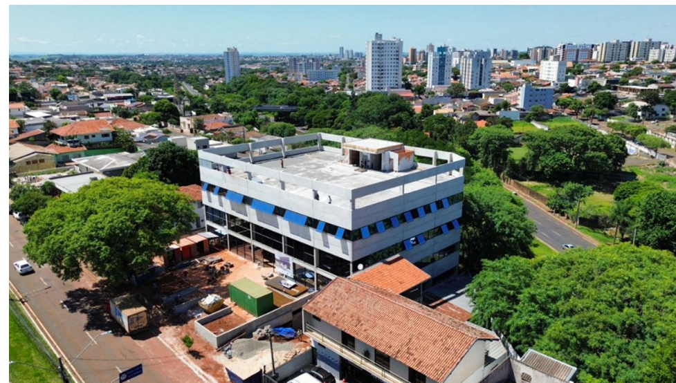
FOTO DA OBRA
