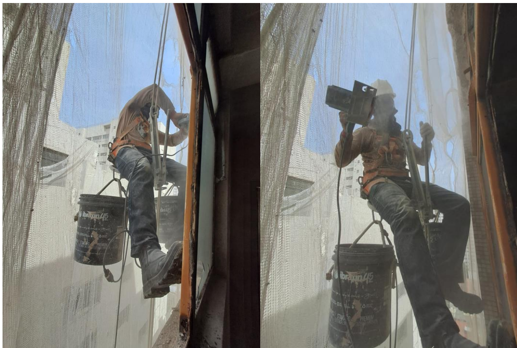
Limpeza e restauro da fachada
