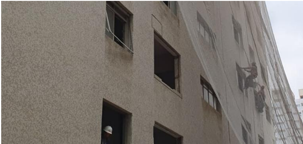
Limpeza e restauro da fachada
