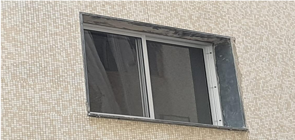
Acabamento em ardósia
