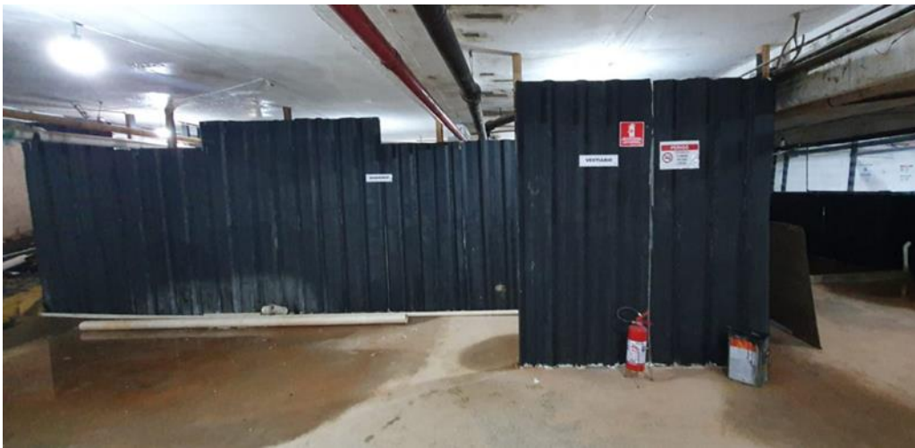
Vestiário e banheiros
