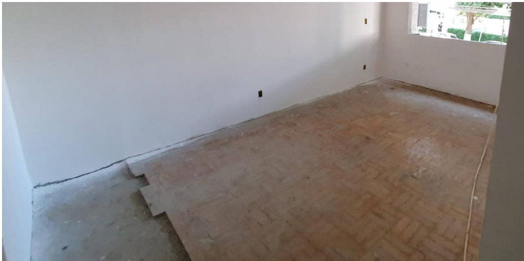
Restauro do piso de madeira
