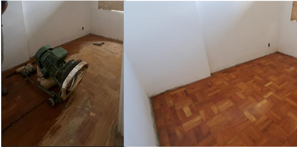
Restauro do piso de madeira
