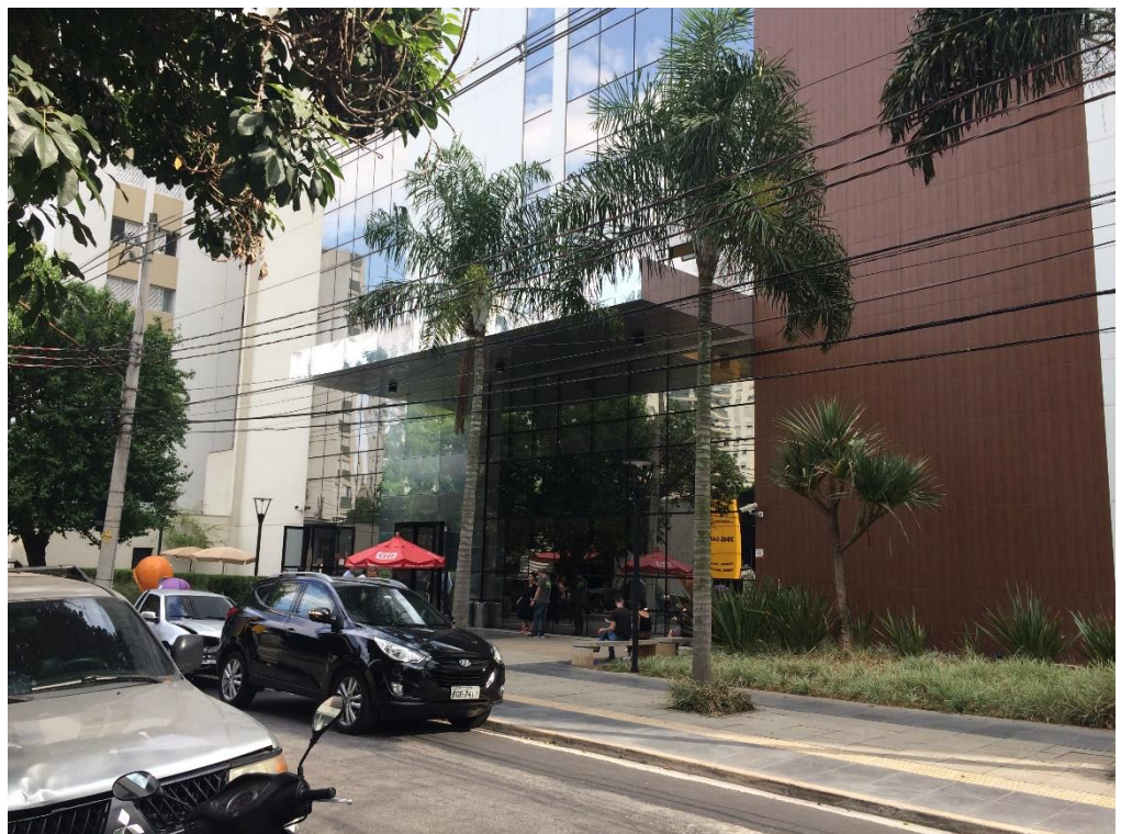
FACHADA – ENTRADA PELA RUA QUATÁ
