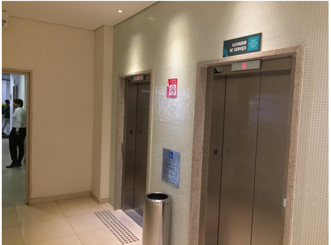
ELVADORES DE SERVIÇO
