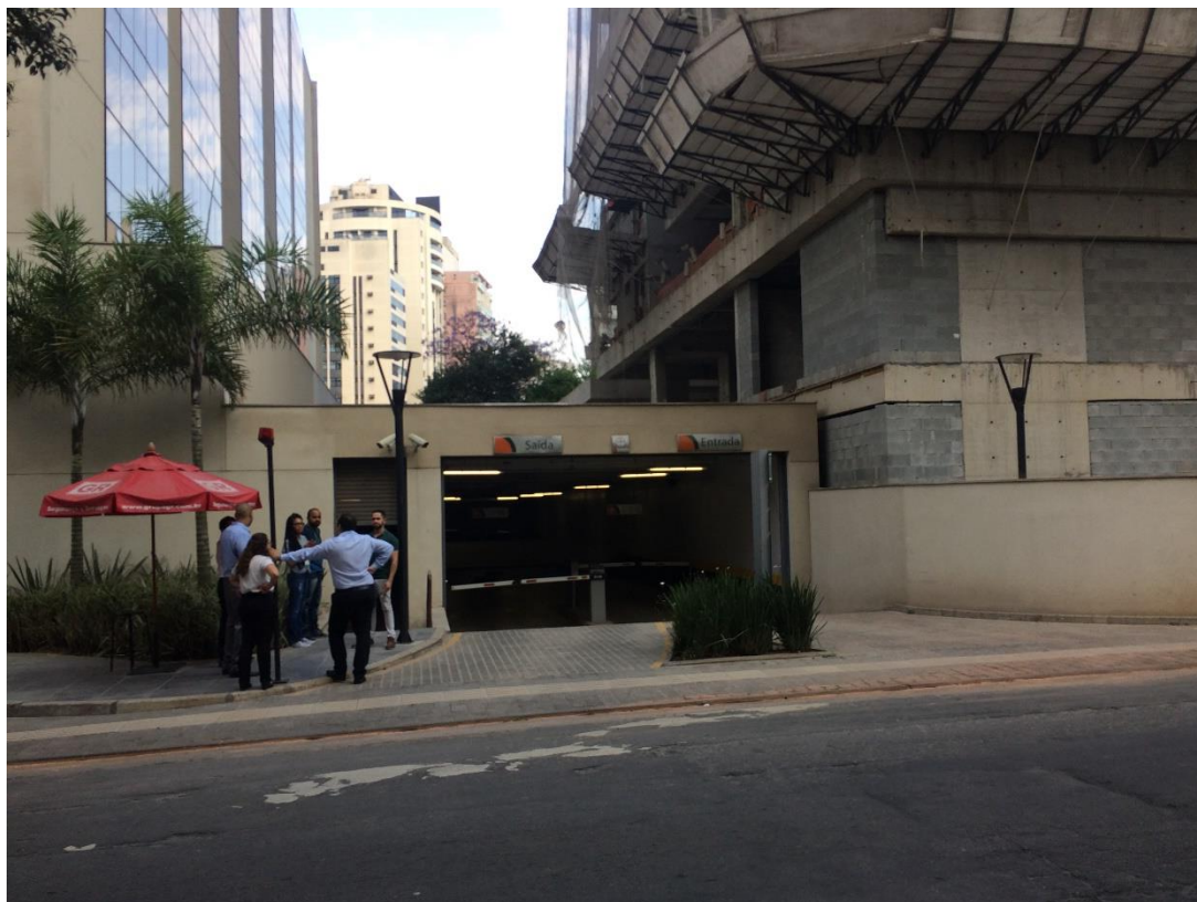
ENTRADA DA GARAGEM – RUA BALUARTE
