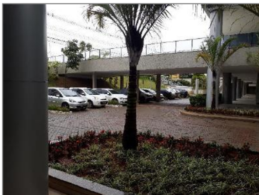
Estacionamento externo térreo
