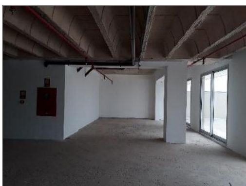
Sala multiuso cobertura (5º pavimento)
