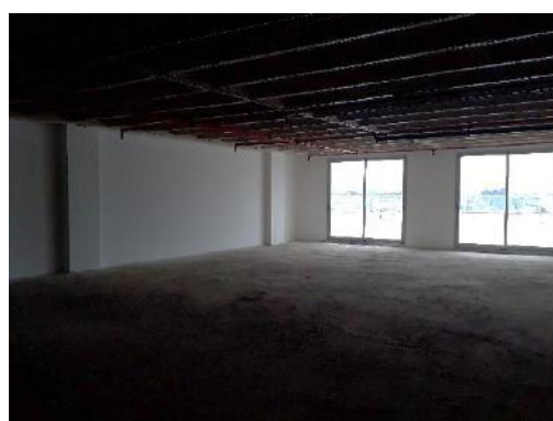
Sala multiuso cobertura (5º pavimento)
