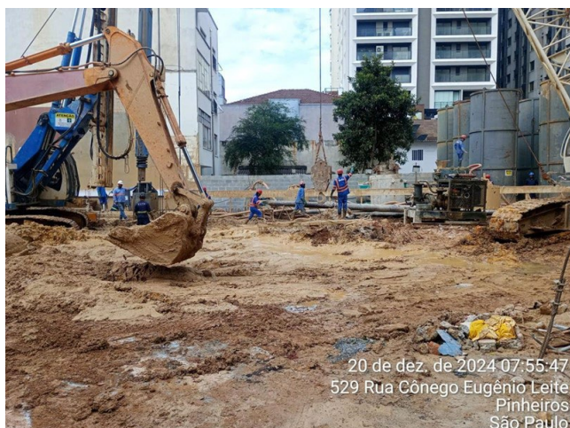
Visão geral do canteiro.
