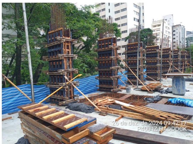
Armação e forma pilares 3º pavimento.
