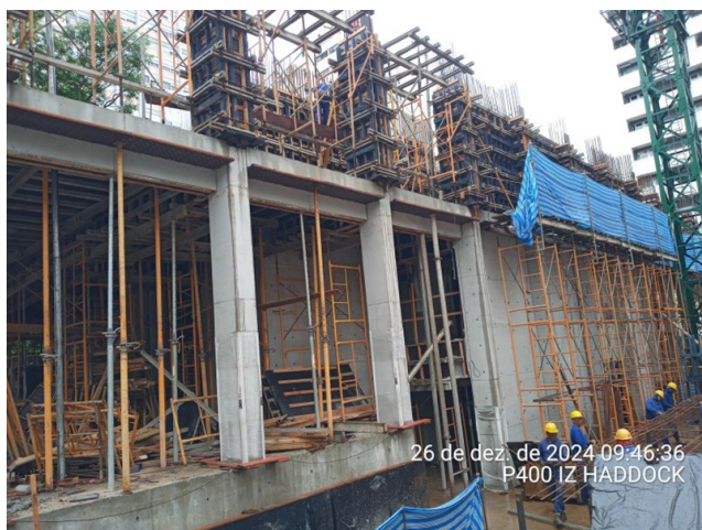
Estrutura do 2º pavimento.
