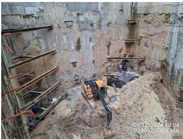
Etapa final de escavação.
