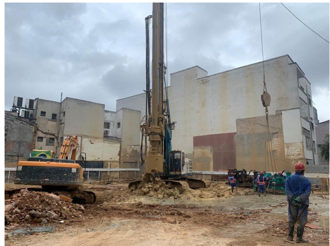
Execução de estacas de fundação.
