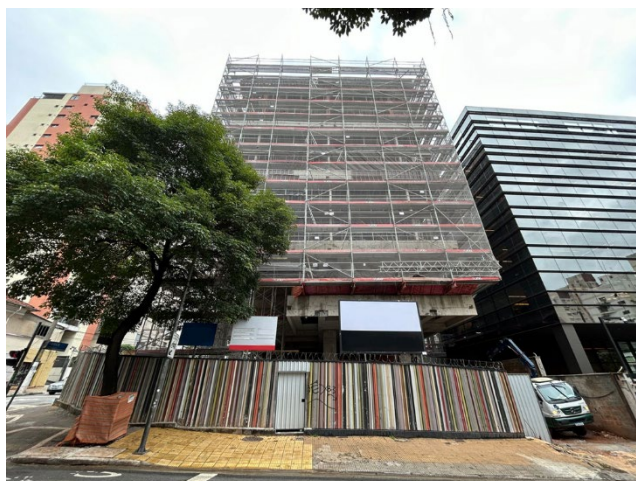
Vista da fachada da Av. 9 de Julho.
