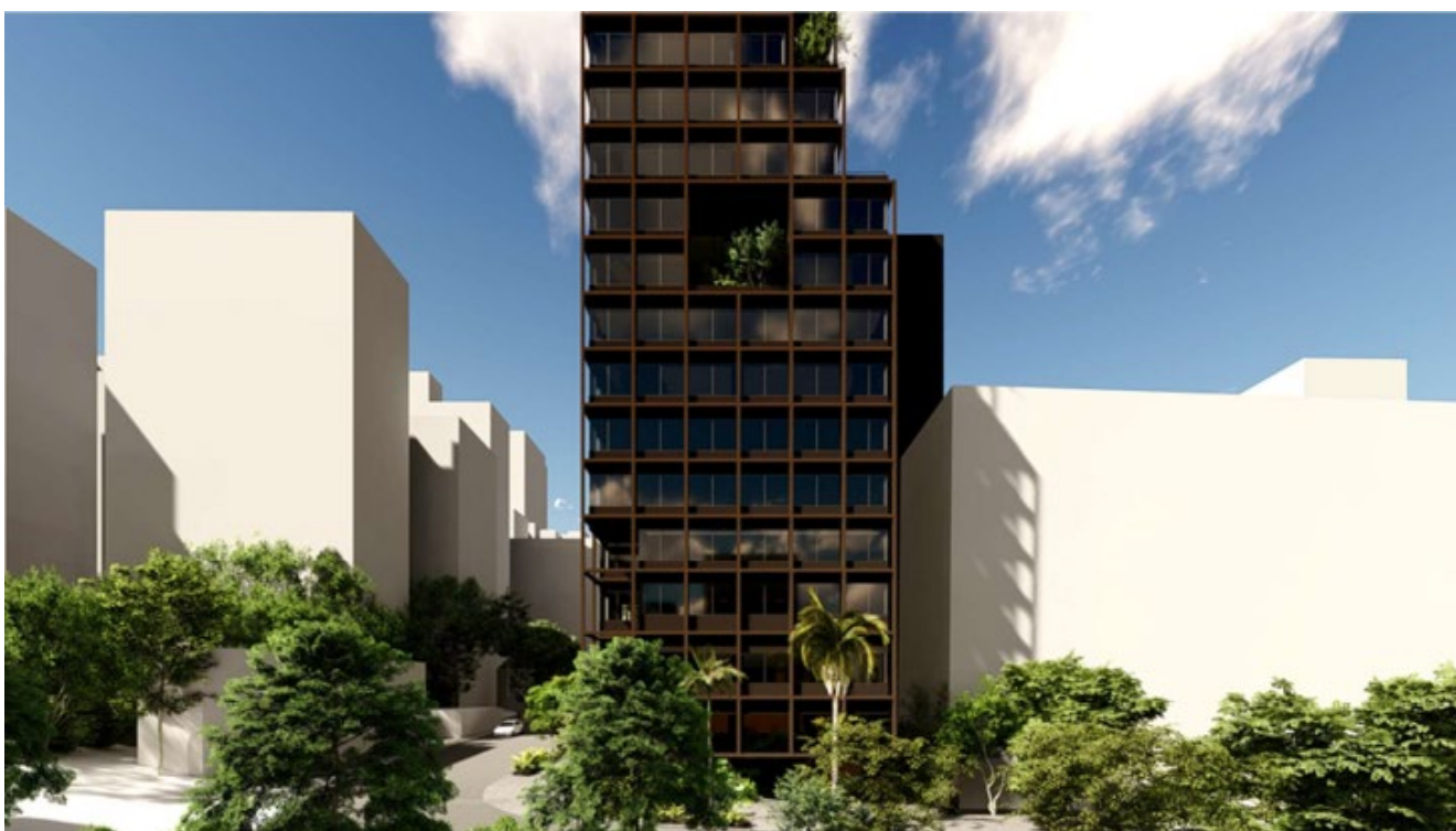
Vista da fachada da Av. 9 de Julho
