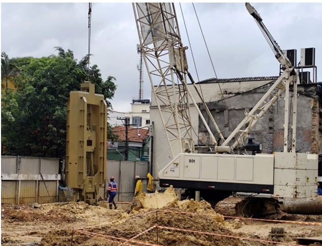
Execução de parede diafragma de contenção.
