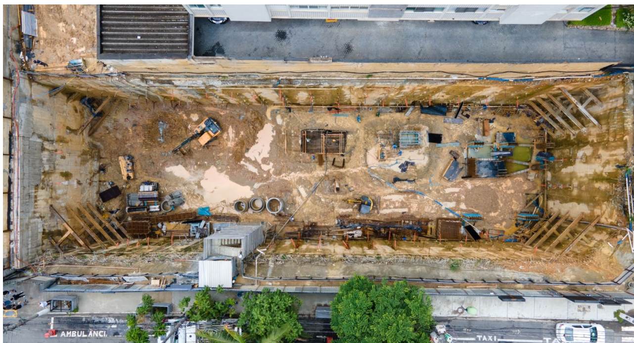
Imagem aérea subsolo. Fonte: Linka
