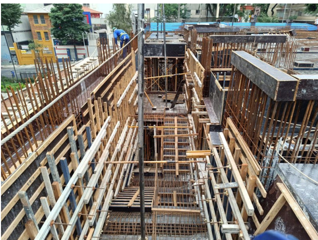
Forma e armação rampa de acesso ao subsolo.
