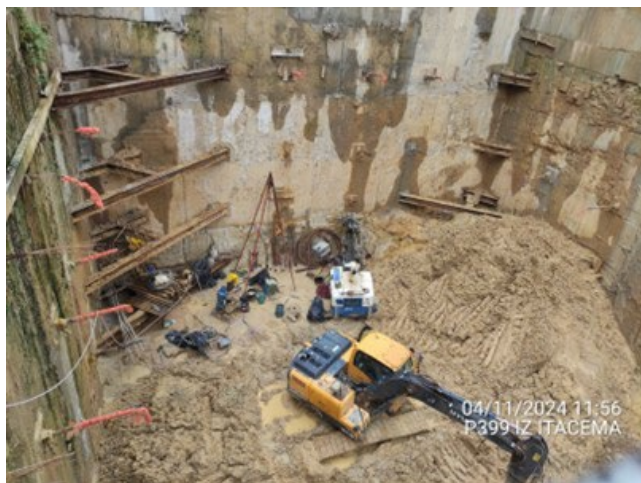
Etapa final de tirantes.
