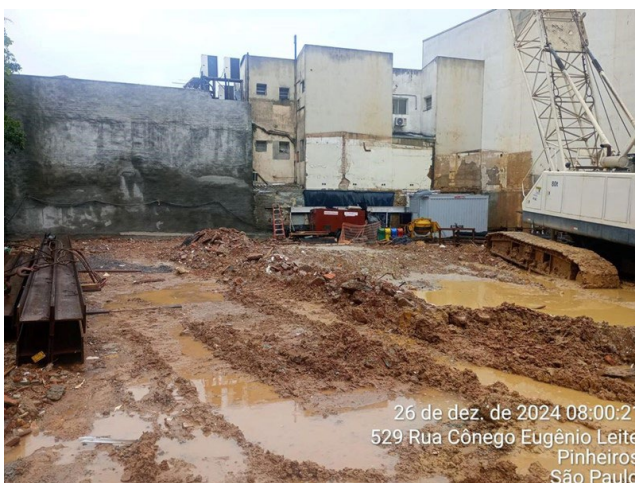
Visão geral do canteiro.
