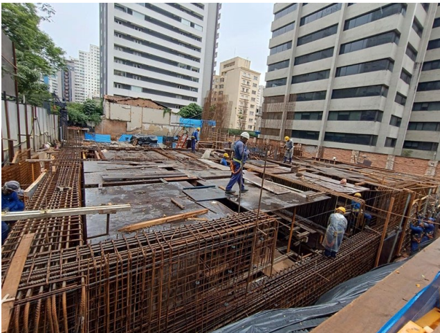
Armação e forma estrutura do 1º pavimento.
