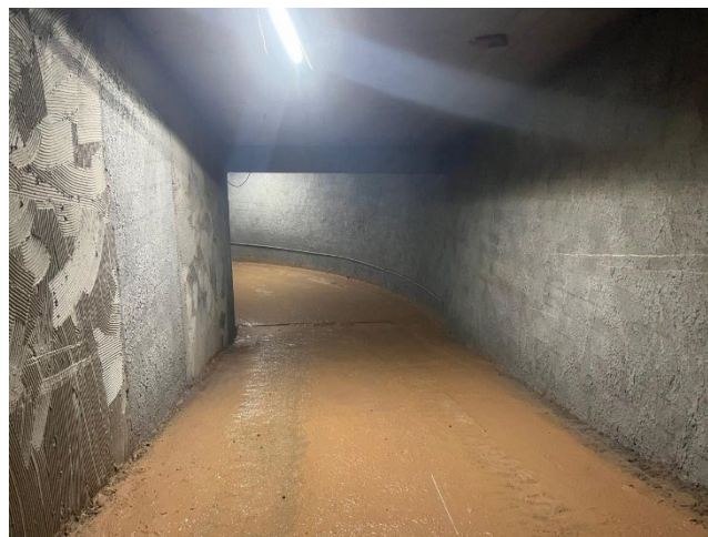
Alvenaria da rampa do 4º Subsolo
