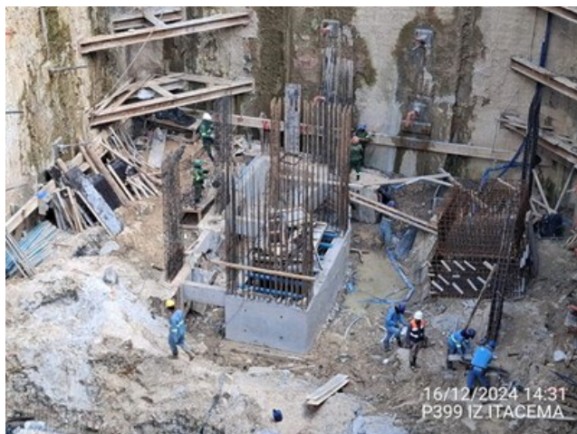
Armação de pilares do 4º subsolo.
