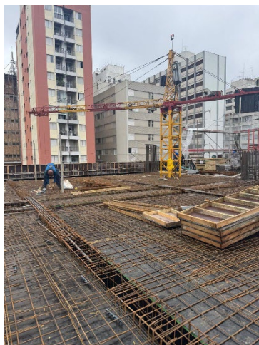
Armação da laje do 6º Pavimento
