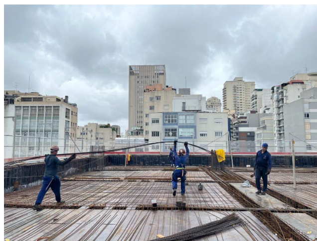
Armação da laje do 8º Pavimento
