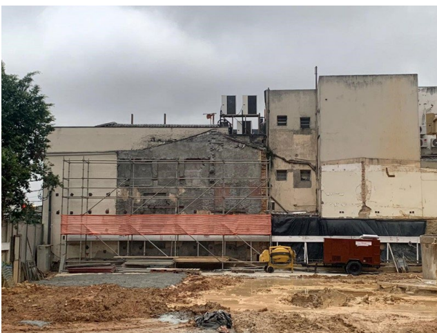
Execução da 1ª etapa de reforço da estrutura vizinha.
