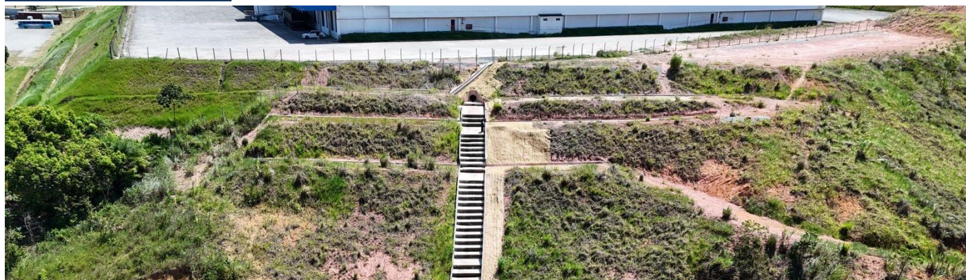
Imagem 6: Reparos no Talude
