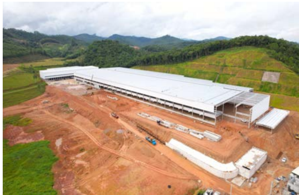
Finalização dos pilares, vigas e lajes pré-moldados do Galpão 1.
