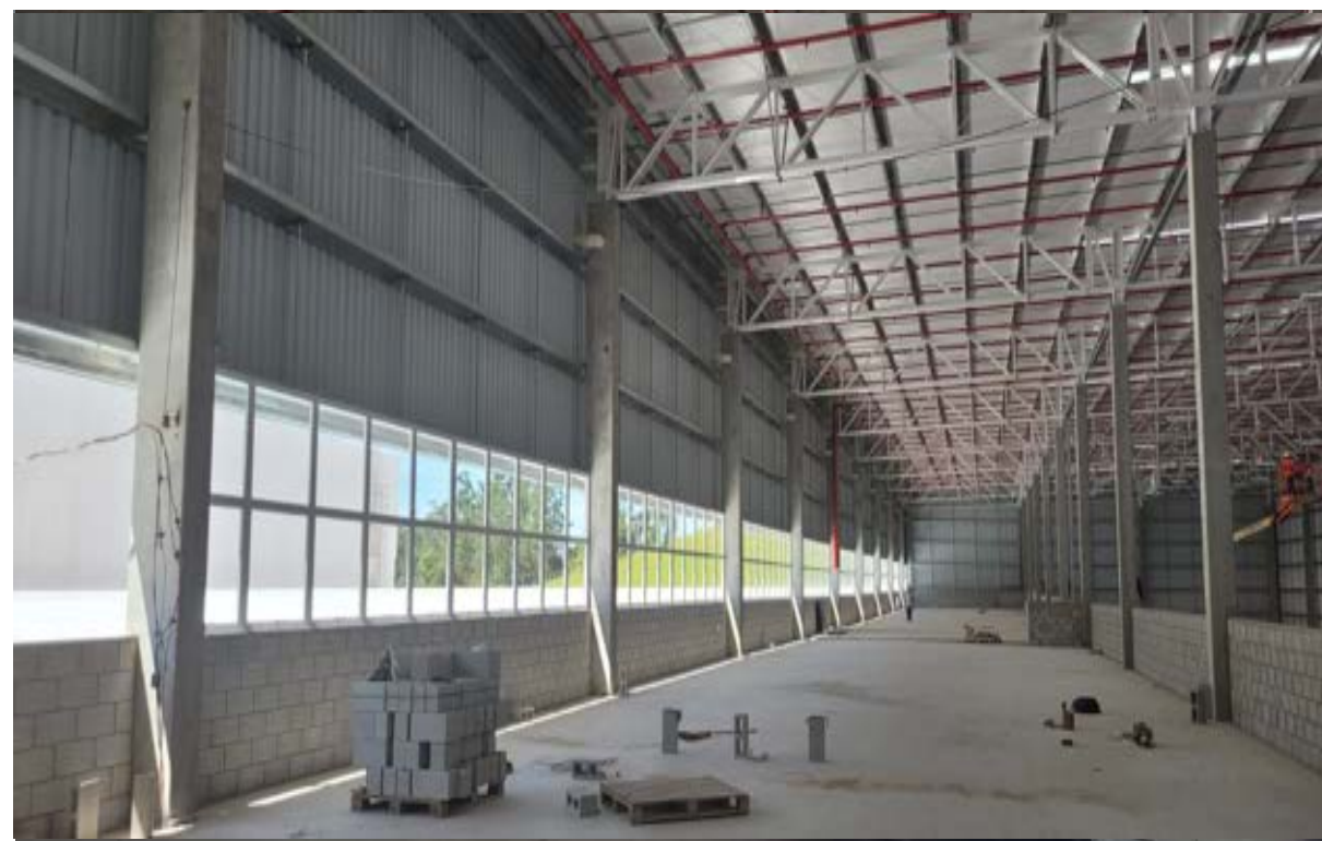
Instalação das esquadrias do mezanino do Galpão 2.
