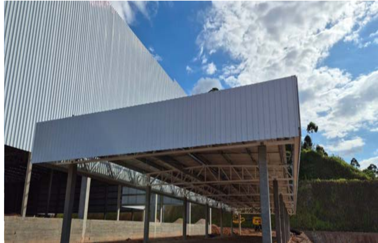
Execução da cobertura do Prédio de Apoio 1.
