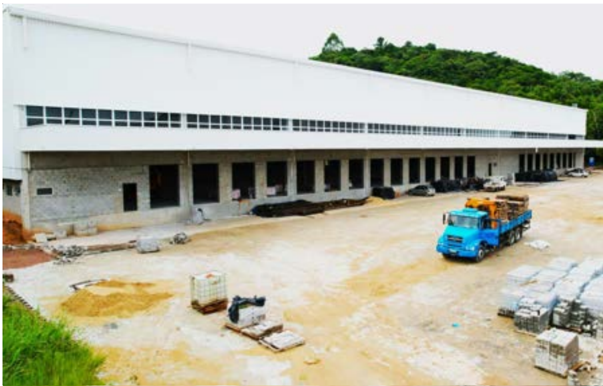
Instalação das esquadrias do mezanino do Galpão 2.
