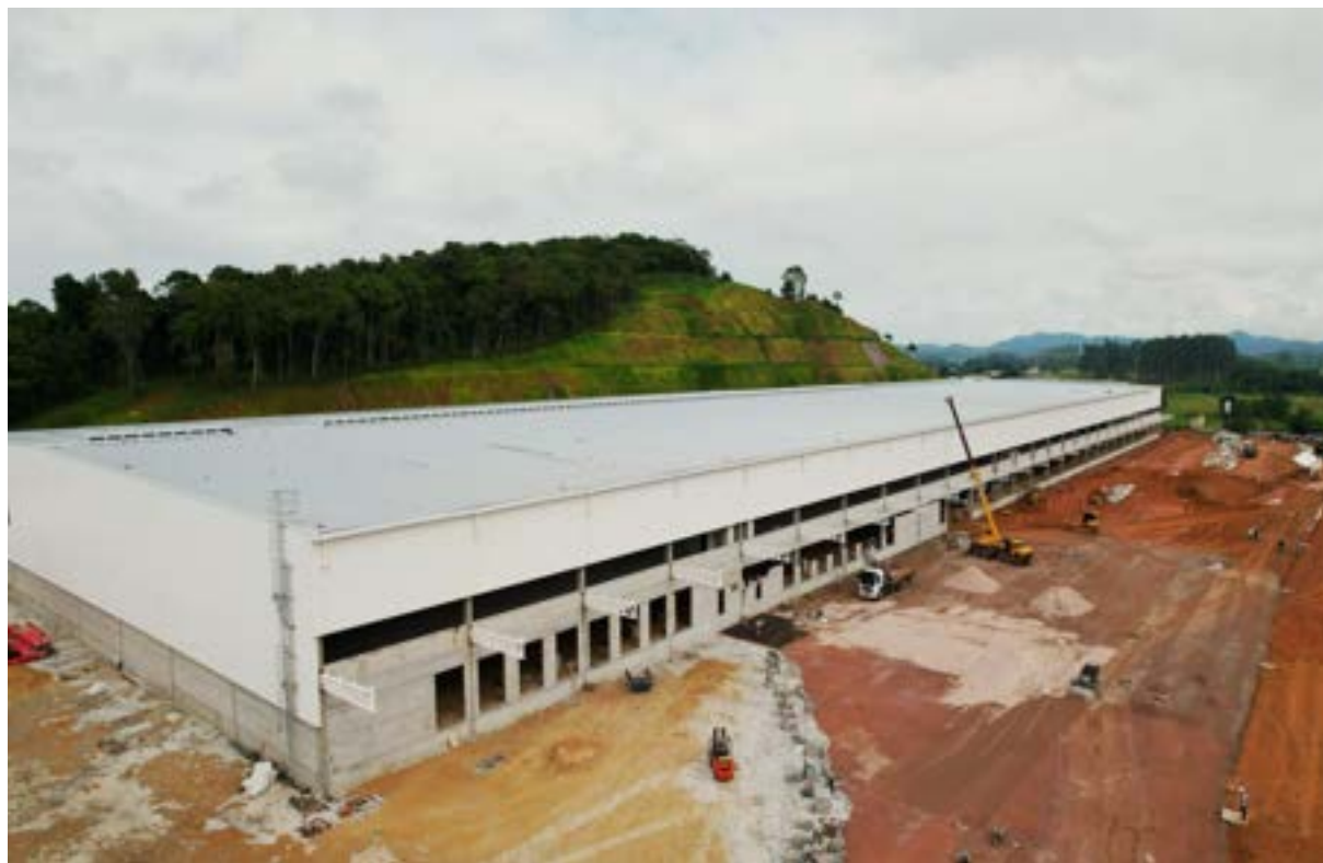
Finalização dos pilares, vigas e lajes pré-moldados do Galpão 1.
