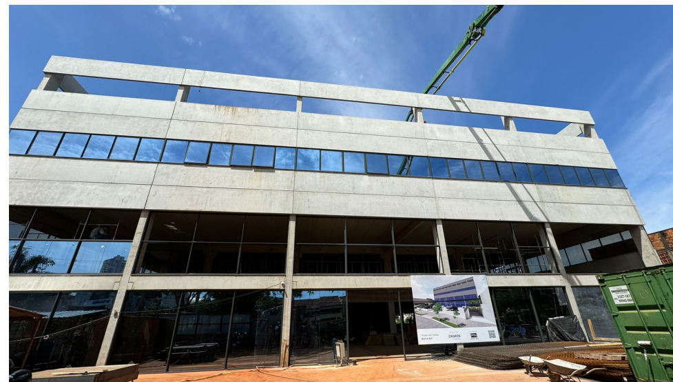
Foto da Obra
