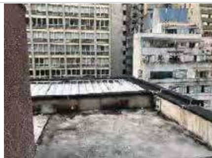
Visão Geral - Cobertura
