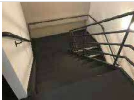
Escada de Emergência
