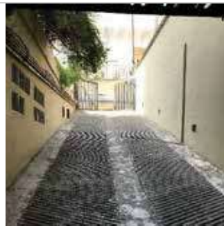
Rampa Para o 1º Subsolo
