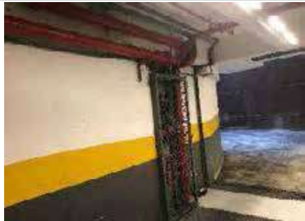
Rampa de acesso - Estacionamento
