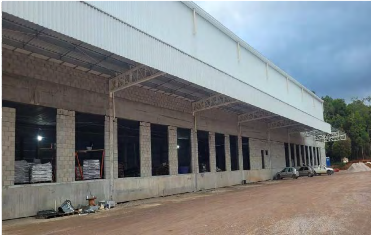
Execução de alvenaria de fechamento do galpão 2.
