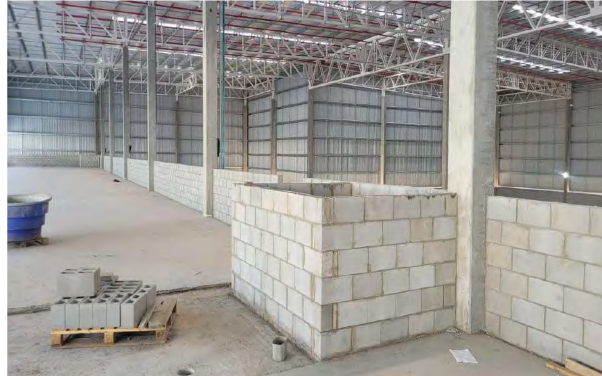
Execução de alvenaria de fechamento do galpão 2.
