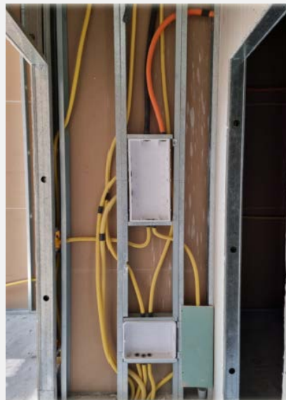
Instalações elétricas (set-out/24)
