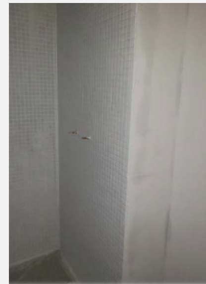
Revestimentos | pastilhas banheiros (nov/24)
