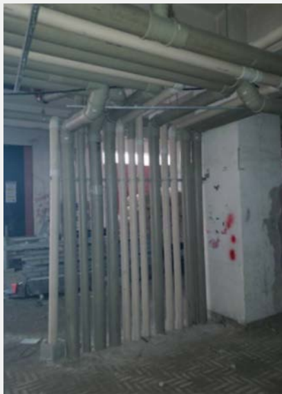
Instalações hidráulicas (nov/24)
