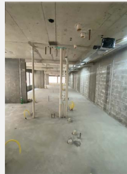
Instalações hidráulicas (out-nov/24)
