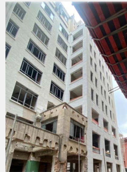
Restauração da fachada (face lateral | set-nov/24)
