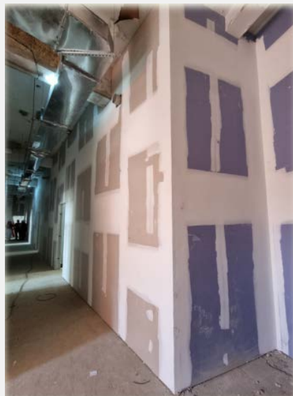
Execução do dry wall das unidades (set - out/24)
