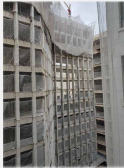
Concretagem estrutura torre C (out-nov/24)
