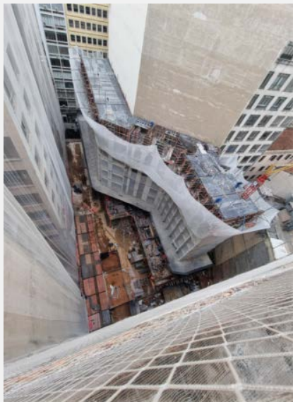
Concretagem estrutura torre C (set/24)
