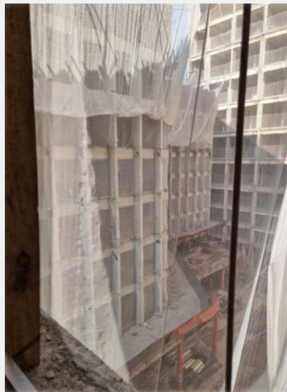
Concretagem estrutura torre C (set/24)
