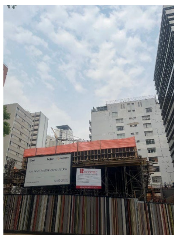
Fachada localizada na Av. 9 de Julho.
