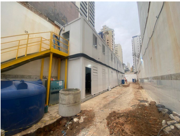
Canteiro de obras.
