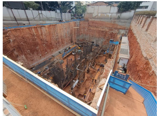
Armação pilares do 4º Subsolo.
