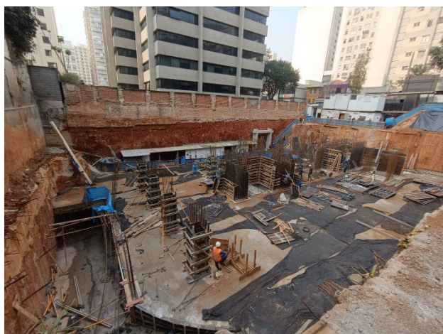
Laje do 2º Subsolo concretada.
