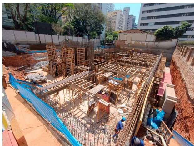
Armação e forma dosilares do Térreo.
