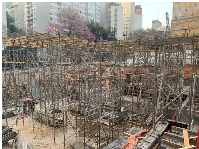
Cimbramento do 1º Pavimento.
