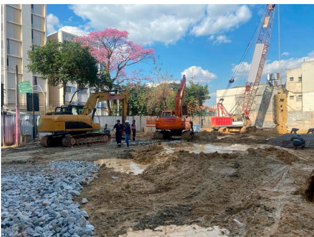
Execução de parede diafragma em agosto/24.
