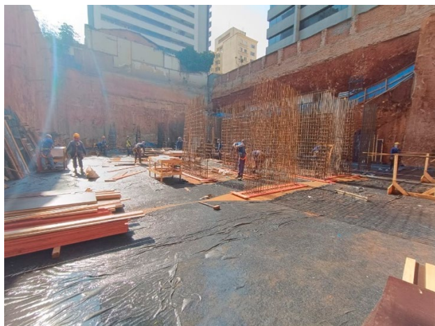
Laje do 4º Subsolo concretada.
