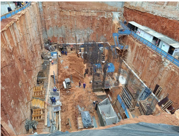
Armação pilares do 5º Subsolo.
