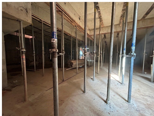
Reescoramento do 1º Subsolo.
