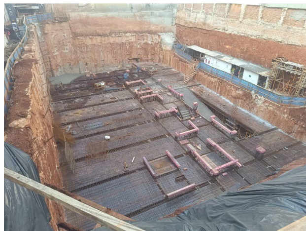
Armação da laje do 3º Subsolo.
