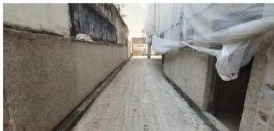
TÉRREO | Demolição Concluída contrapiso, manta asfáltica existente aparente.
