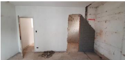
TORRE 484 - 10º. PAV | Demolição Concluída
