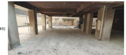
TÉRREO | Demolição Concluída contrapiso, manta asfáltica existente aparente.
