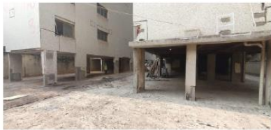
TÉRREO | Demolição Concluída contrapiso, manta asfáltica existente aparente.
