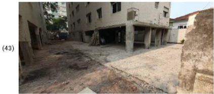
TÉRREO | Demolição Concluída contrapiso, manta asfáltica existente aparente.
