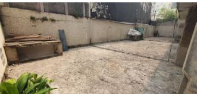
TÉRREO | Demolição Concluída contrapiso, manta asfáltica existente aparente.
