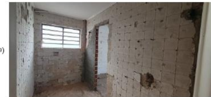
TORRE 484 - 10º. PAV | Demolição Concluída
