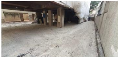
TÉRREO | Demolição Concluída contrapiso, manta asfáltica existente aparente.
