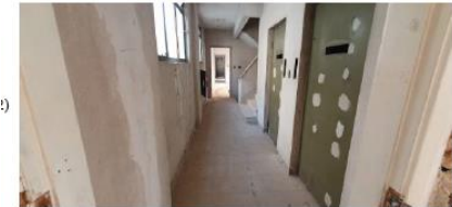
TORRE 484 - 10º. PAV | Demolição Concluída
