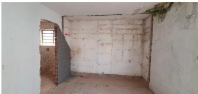
TORRE 484 - 10º. PAV | Demolição Concluída
