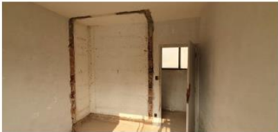
TORRE 484 - 10º. PAV | Demolição Concluída
