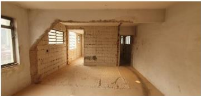
TORRE 484 - 10º. PAV | Demolição Concluída
