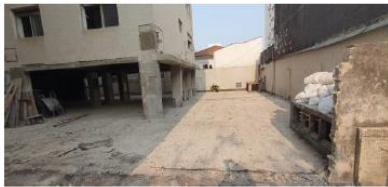
TÉRREO | Demolição Concluída contrapiso, manta asfáltica existente aparente.
