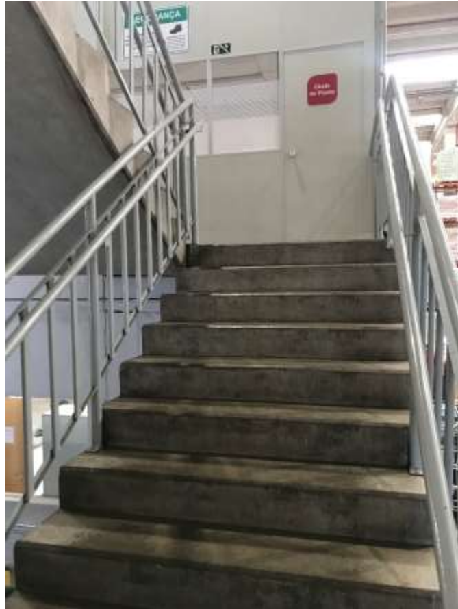
VISTA DA ESCADA DE ACESSO AO MEZANINO
