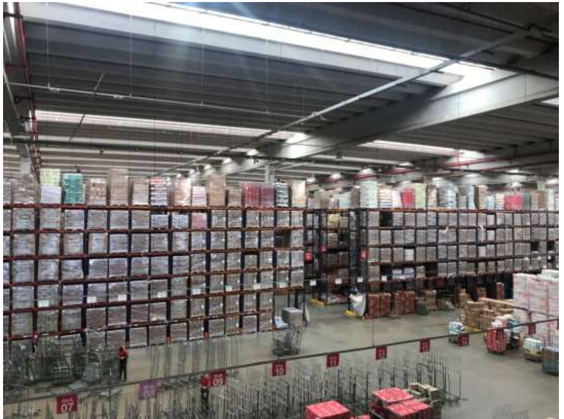
VISTA INTERNA DO GALPÃO
