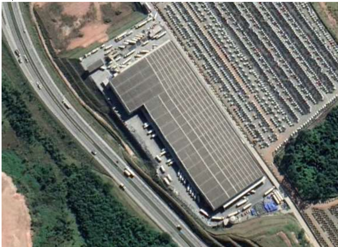
FOTO AÉREA DO IMÓVEL
