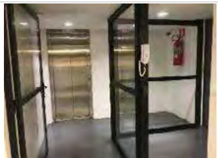
Hall de elevadores - subsolo
