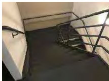
Escada de Emergência
