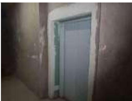
Hall e elevador de serviço
