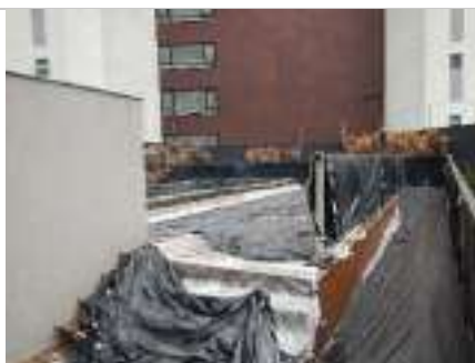
Piscina (em construção)
