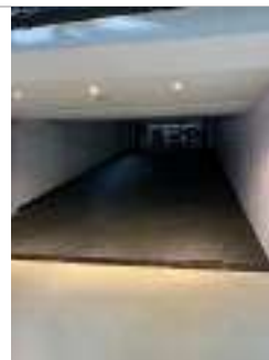
Rampa de Acesso Garagem
