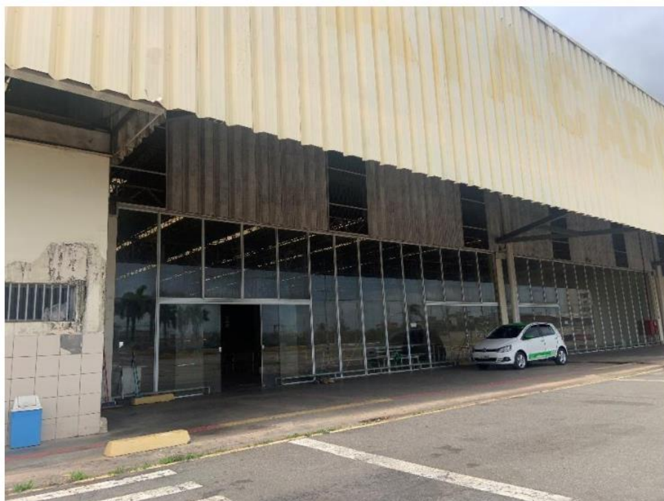
Vista Geral da Fachada do Imóvel
