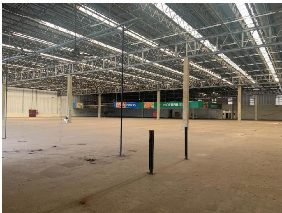
Vista Geral interna
