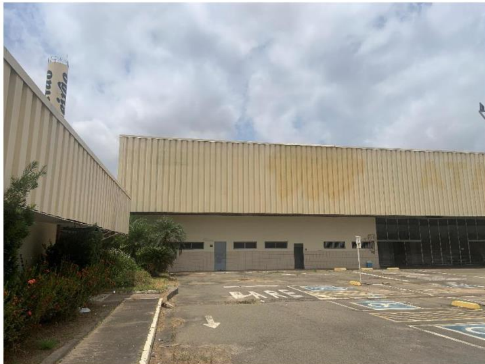
Vista Geral da Fachada do Imóvel
