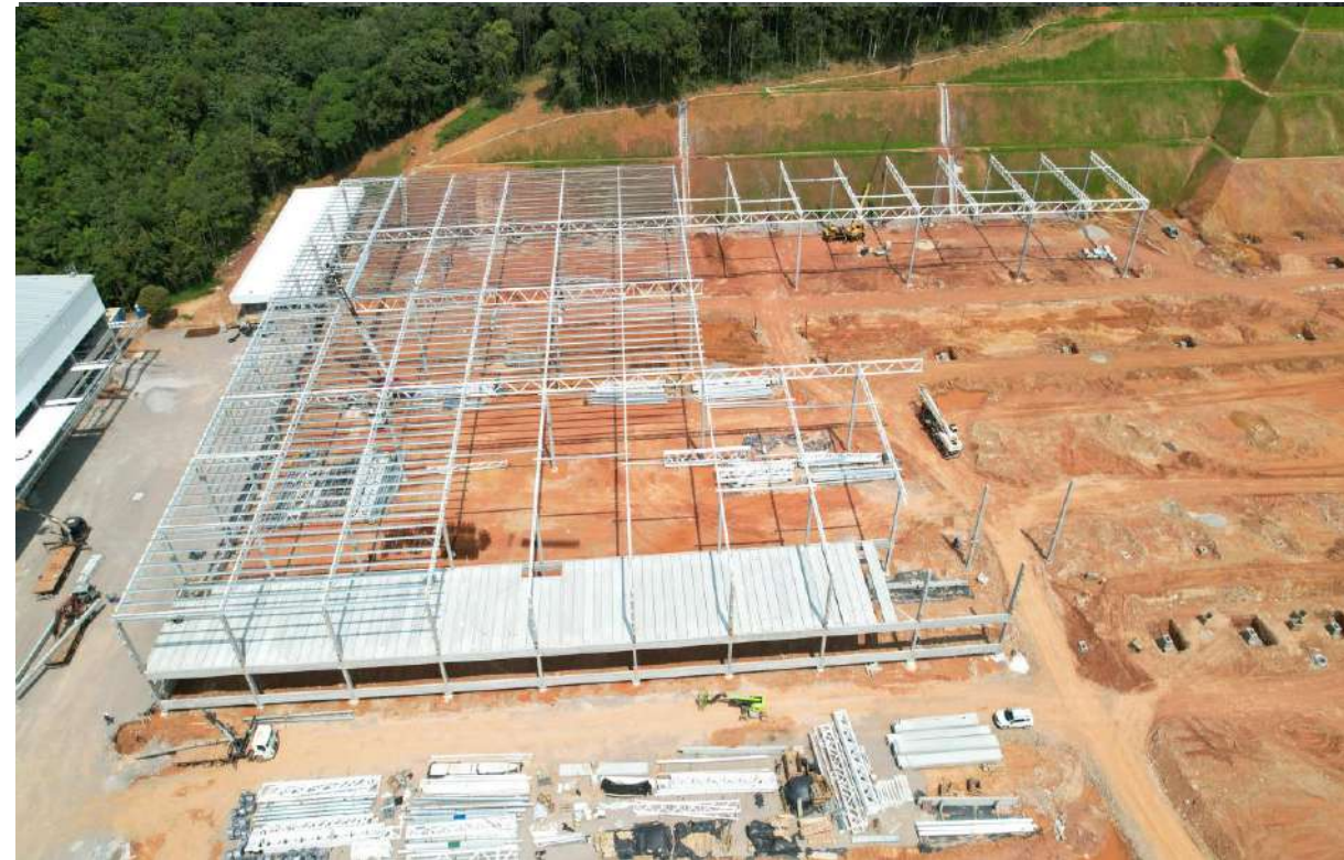
lçamento dos pilares, vigas e lajes pré-moldados do galpão 1.
