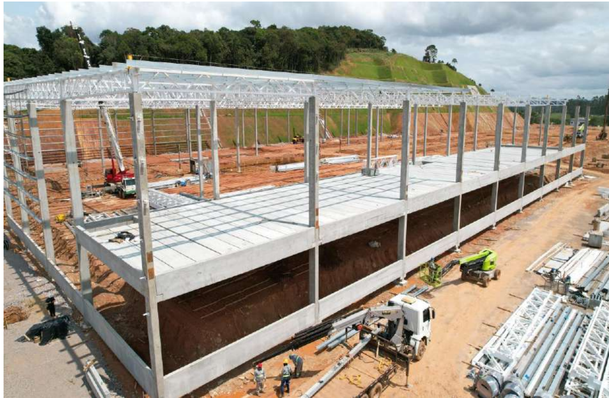
lçamento dos pilares, vigas e lajes pré-moldados do galpão 1.
