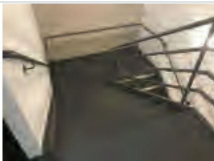
Escada de Emergência
