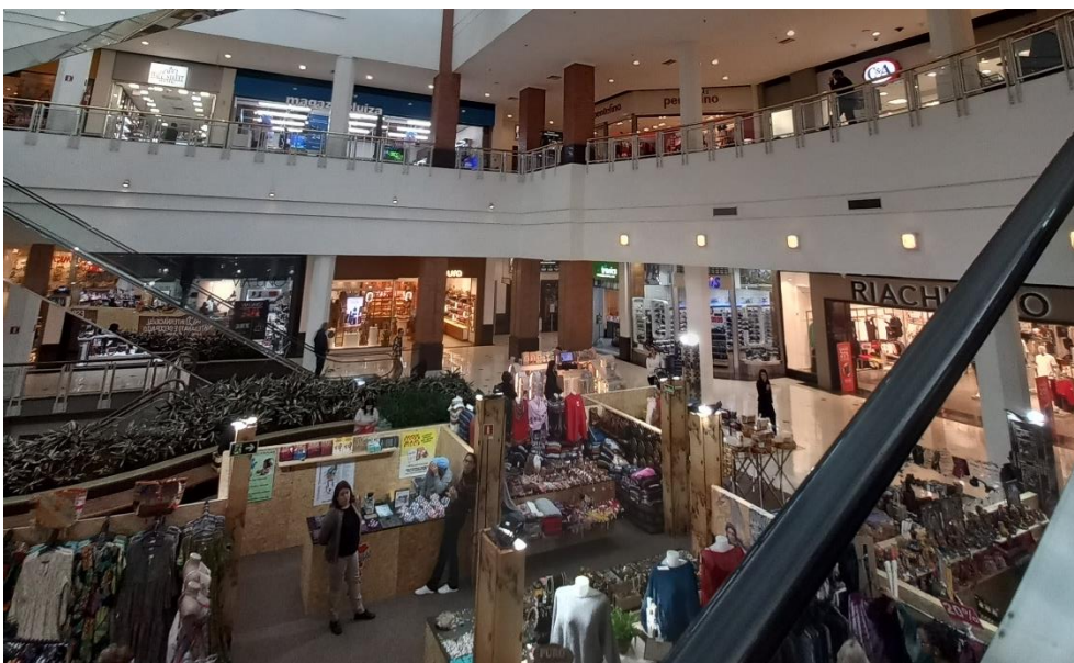
Vista interna do imóvel
