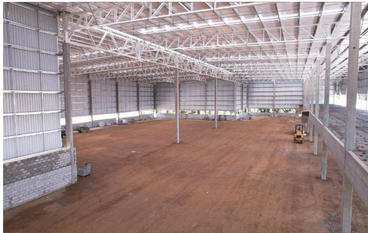
Execução de alvenaria de fechamento do galpão 2.
