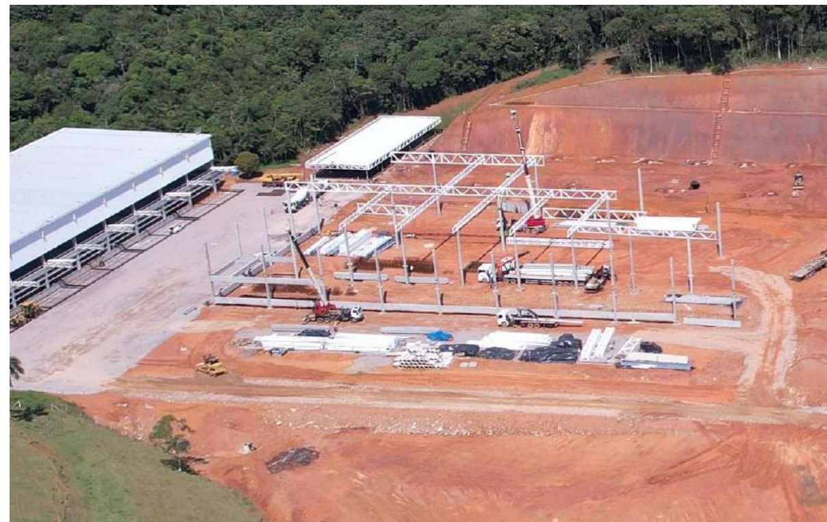
lçamento dos pilares pré-moldados do galpão 1.
