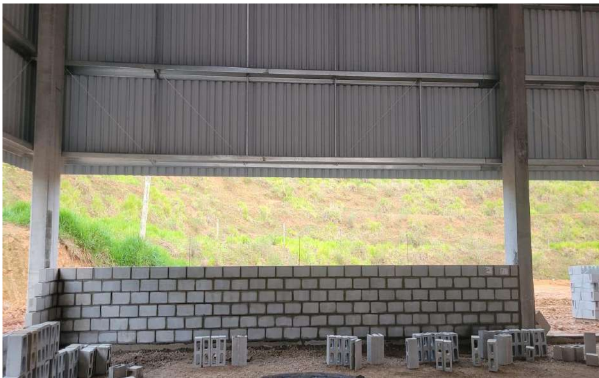
Execução de alvenaria de fechamento do galpão 2.
