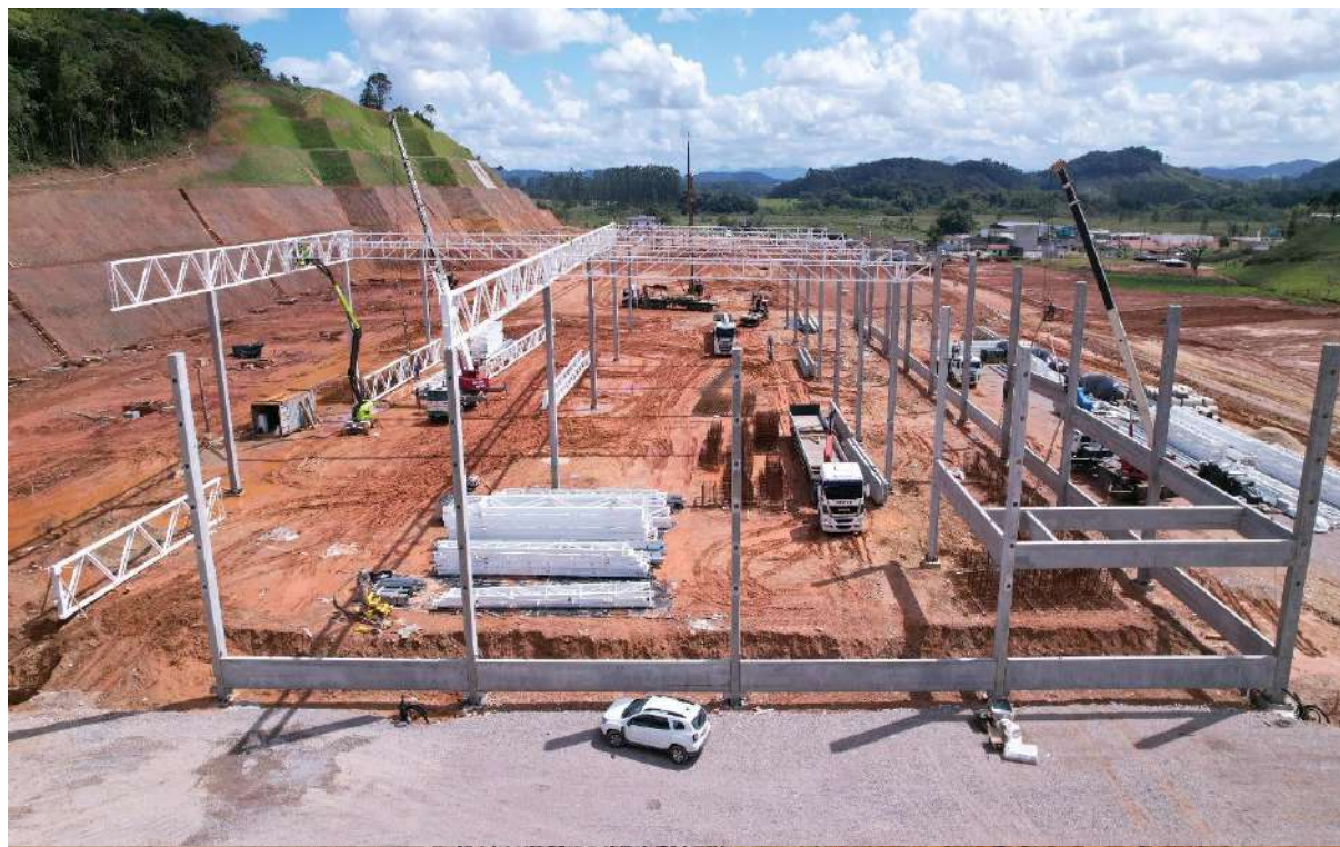
lçamento dos pilares pré-moldados do galpão 1.
