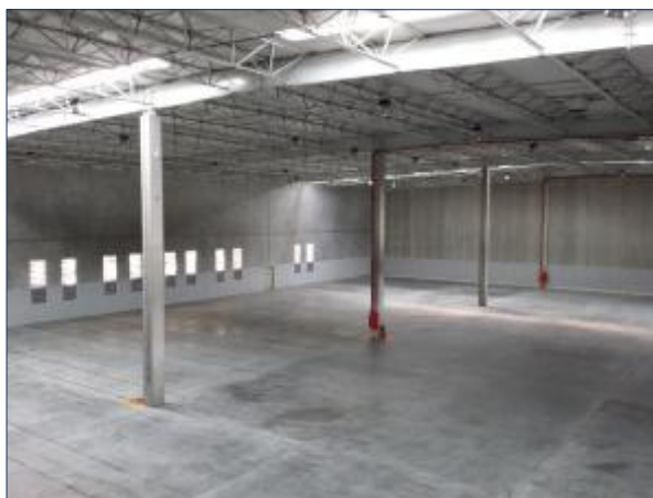
Interior do Galpão
