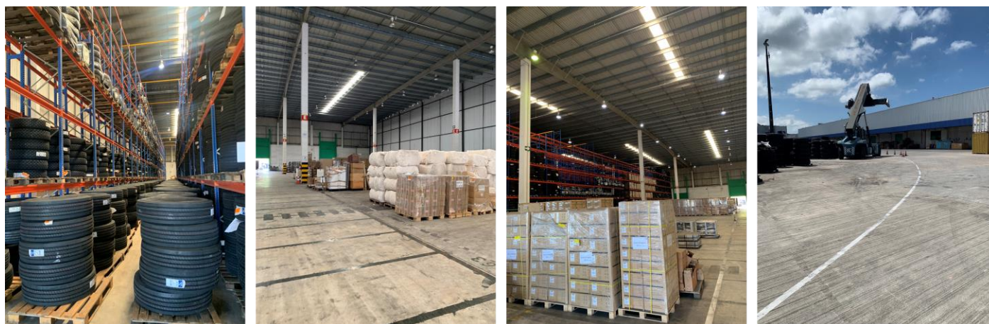
Imagem 4: Fotos Internas dos Galpões
