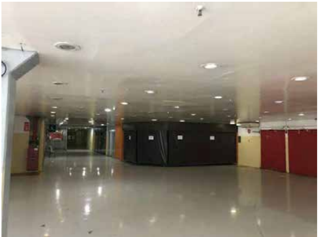
ÁREA DE GALERIAS
