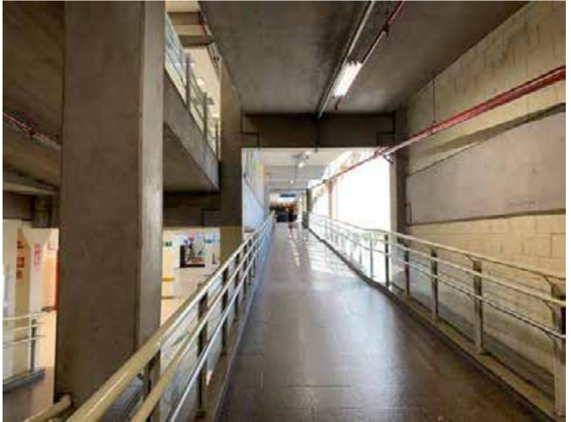
RAMPA DE ACESSO À LOJA
