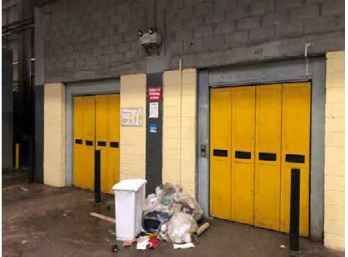
ELEVADOR DE CARGA
