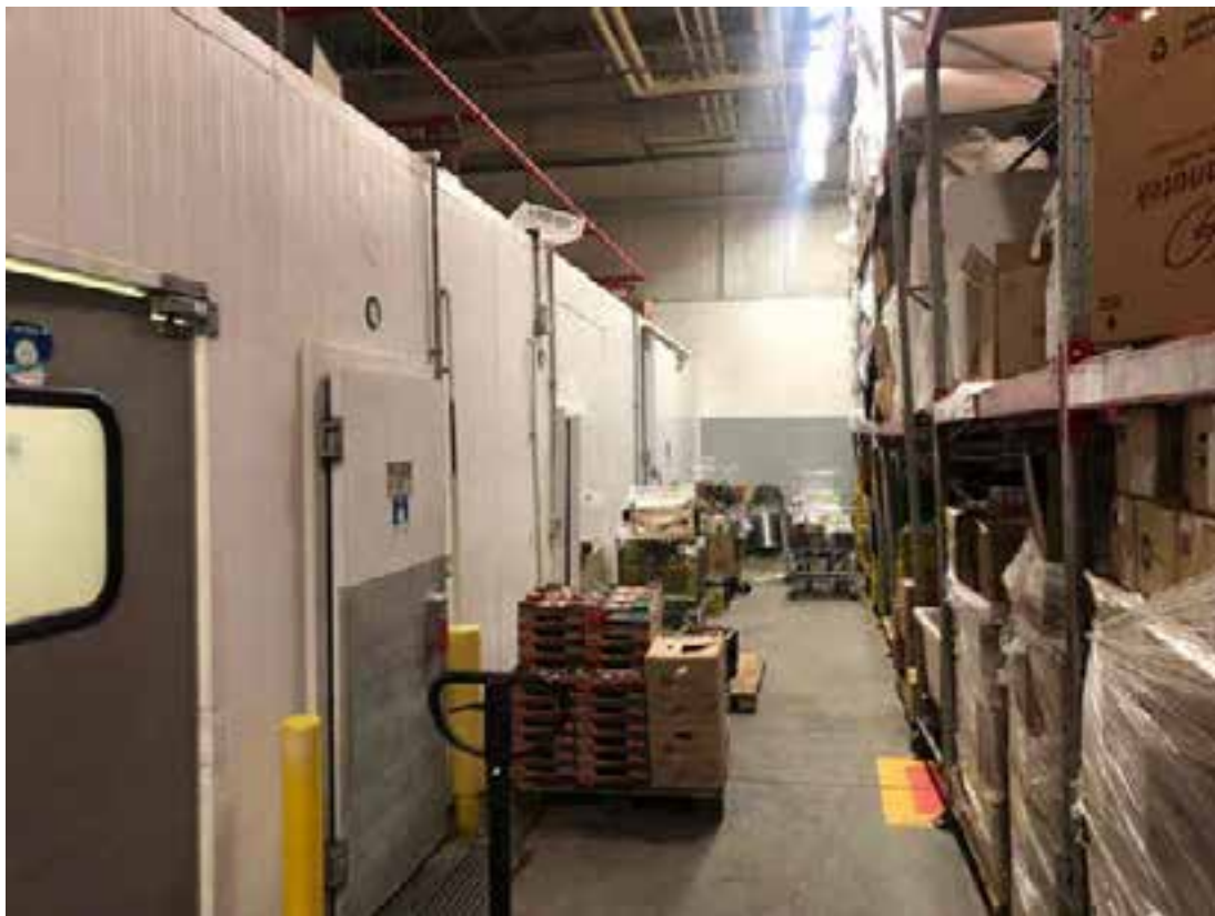
ACESSO ÀS CÂMARAS FRIAS
