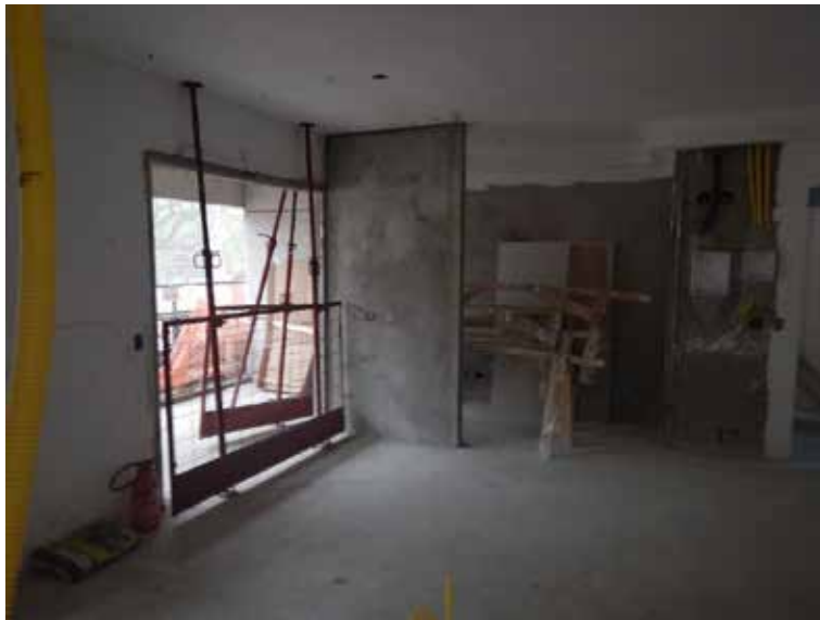
Visão Geral da Unidade
