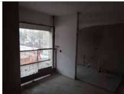
Vista da unidade
