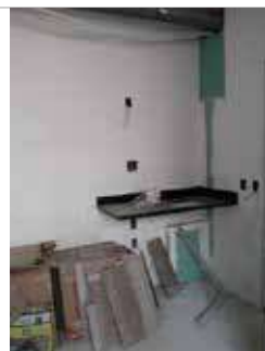
Vista da unidade
