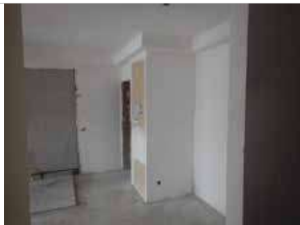
Vista da unidade
