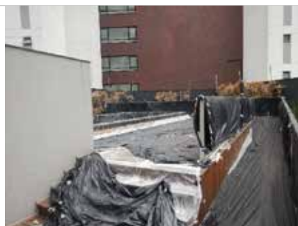
Piscina (em construção)
