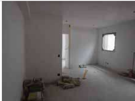
Vista da unidade
