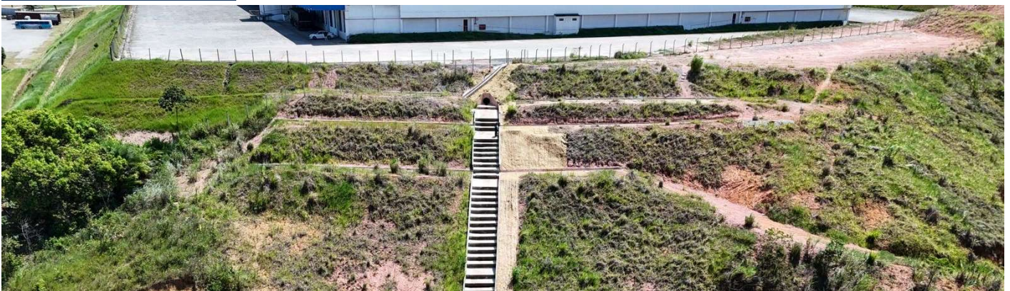
Imagem 6: Reparos no Talude
