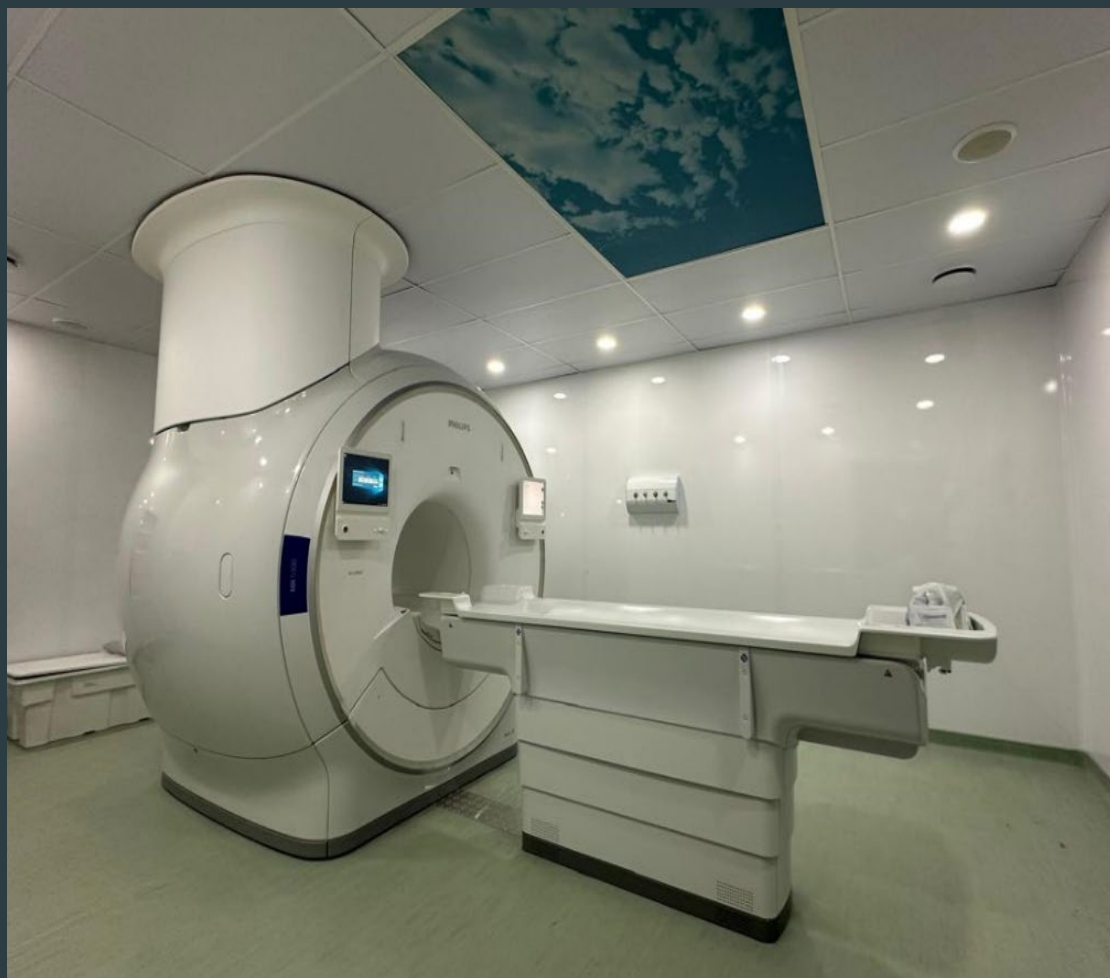
Execução Sala da Ressonância
