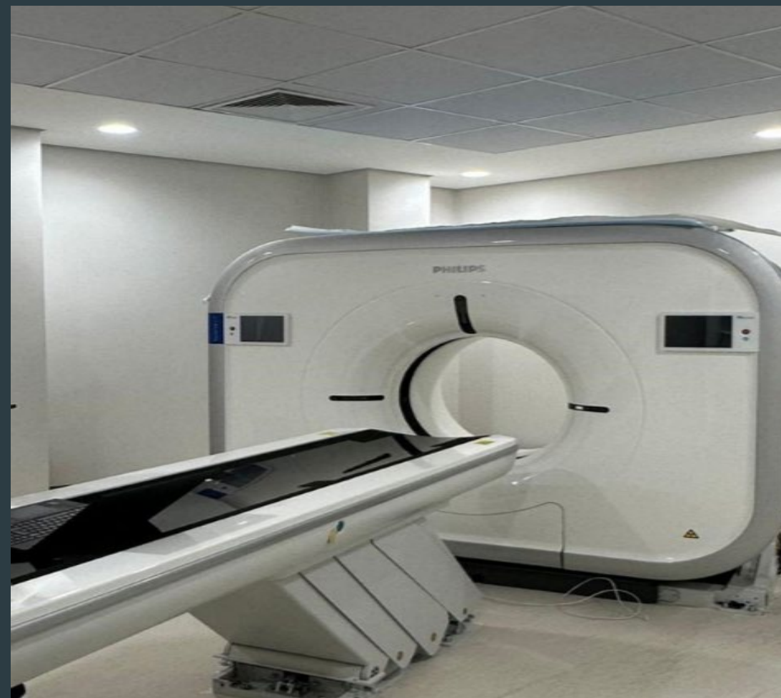
Execução da Sala de Tomografia
