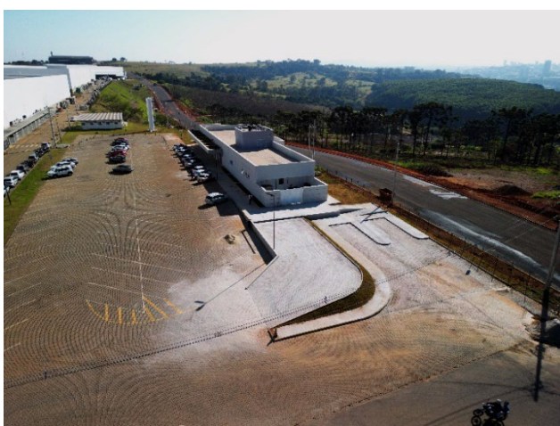
Foto obra carga e descarga do restaurante no Citlog Sul de Minas.
