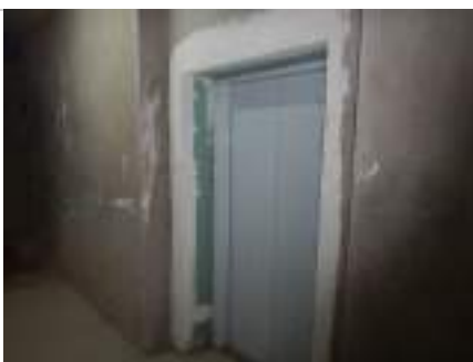
Hall e elevador de serviço
