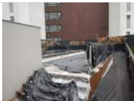
Piscina (em construção)
