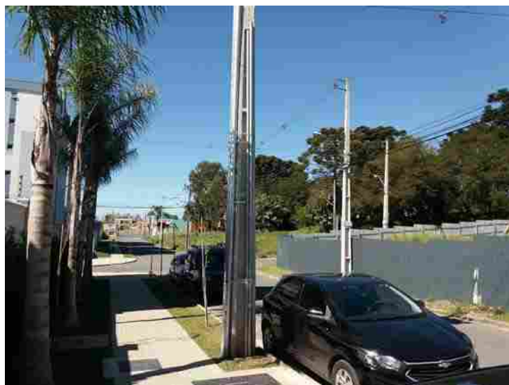
Rua Casemiro Augusto Rodacki, com o imóvel à esquerda
