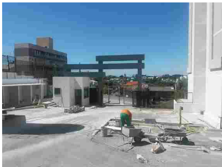
Vista do acesso externo do imóvel
