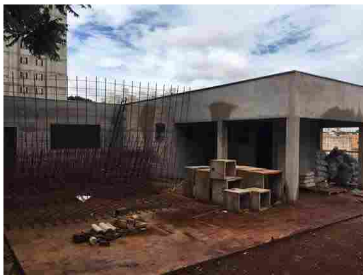
Vista geral do imóvel
