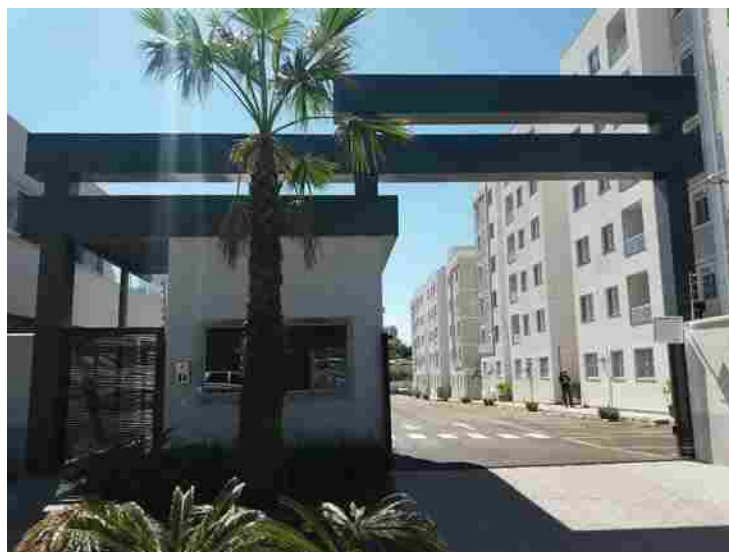
Frente do imóvel para Rua Casemiro Augusto Rodacki
