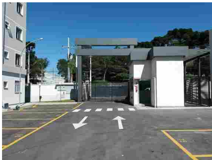
Vista do acesso externo do imóvel
