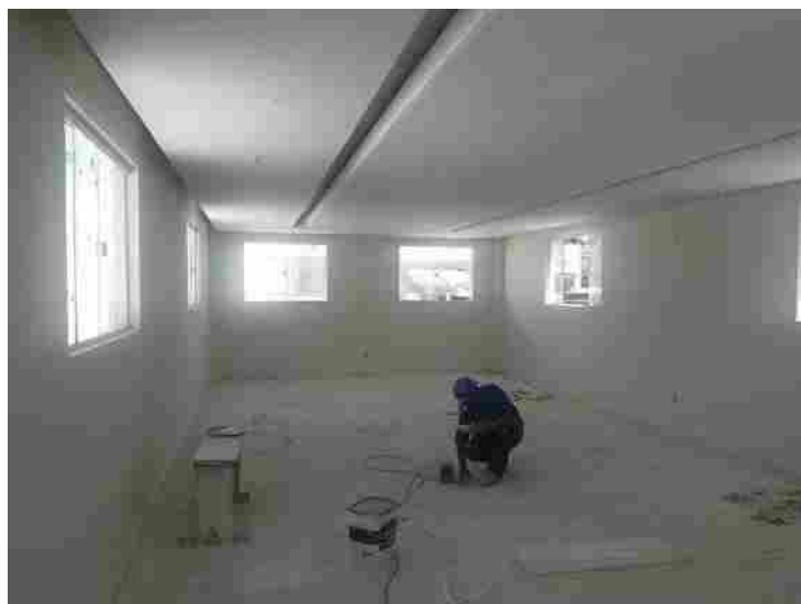
Vista da área interna
