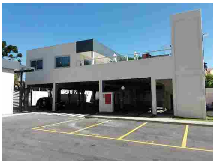
Vista do acesso para o estacionamento coberto
