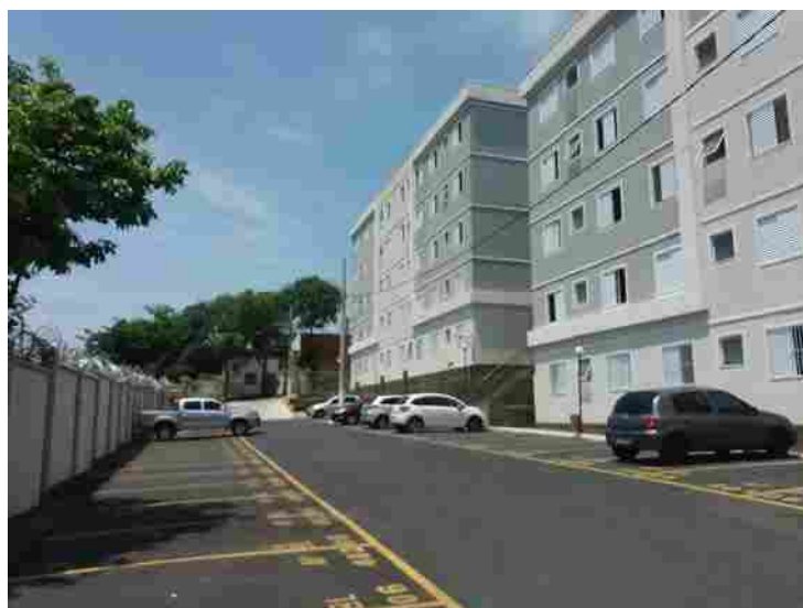
Pátio de estacionamento
