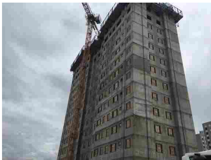
Vista geral do imóvel
