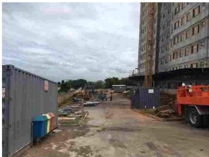
Vista geral do imóvel
