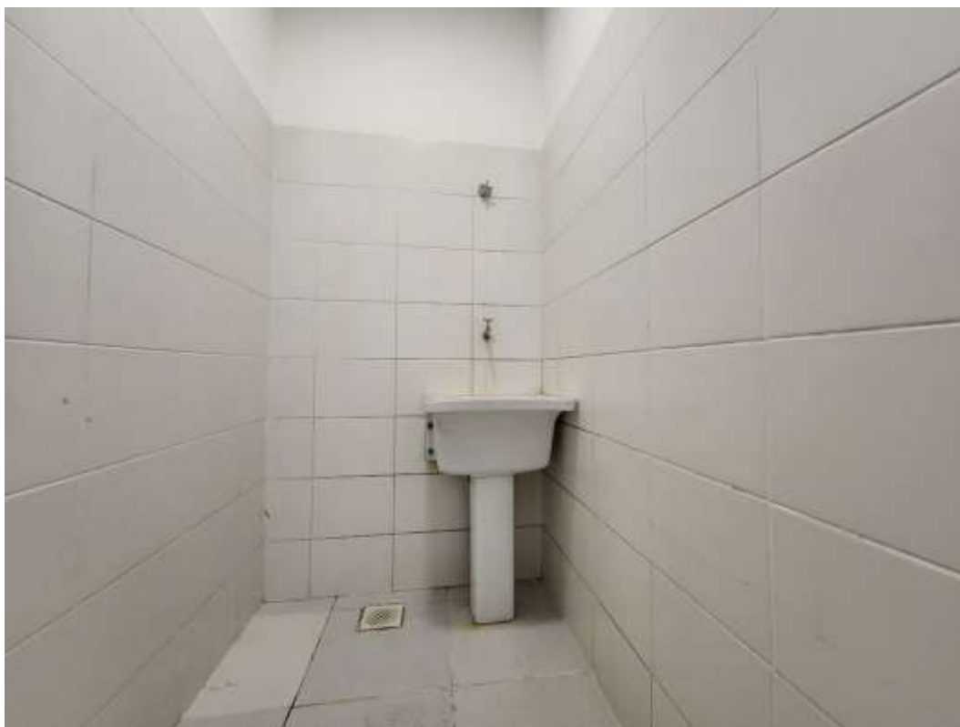
Vista da área interna do galpão
