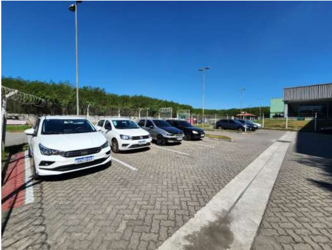
Vista da área externa do imóvel
