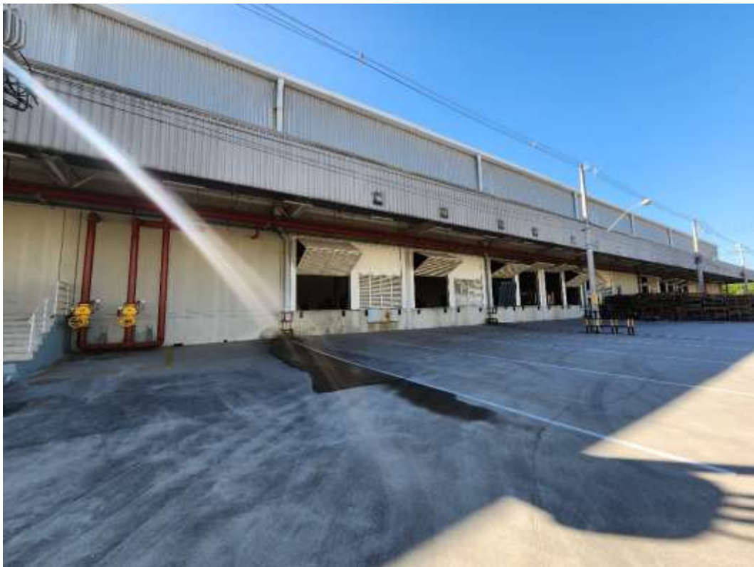
Vista da área externa do imóvel
