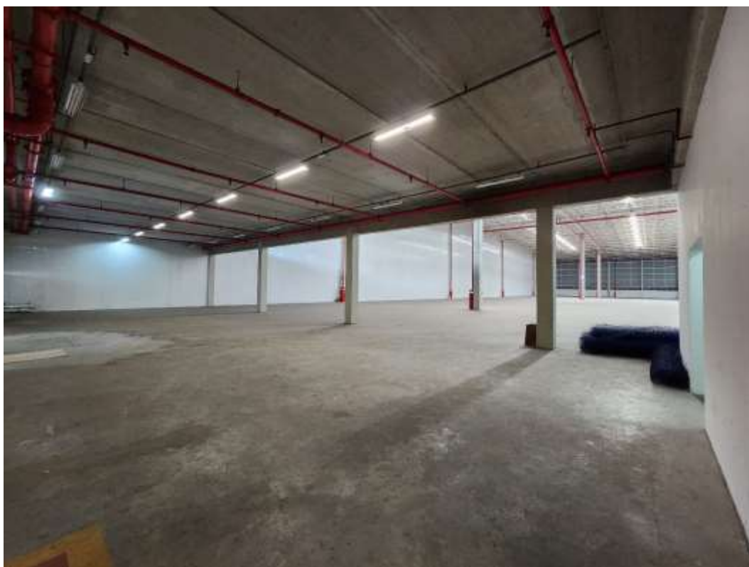
Vista da área interna do galpão
