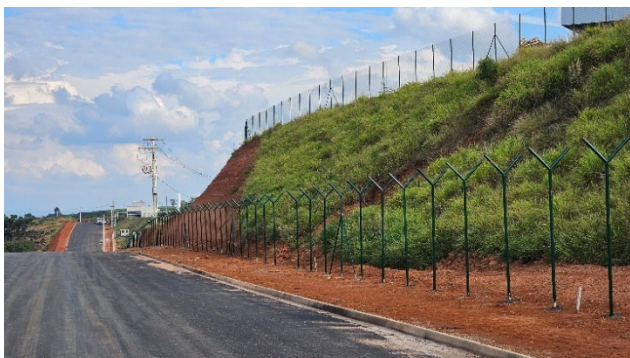
Fotos da via em obra.
