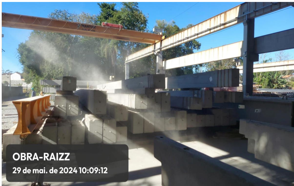
Fabricação das peças pré-moldadas dos galpões 1 e 2.
