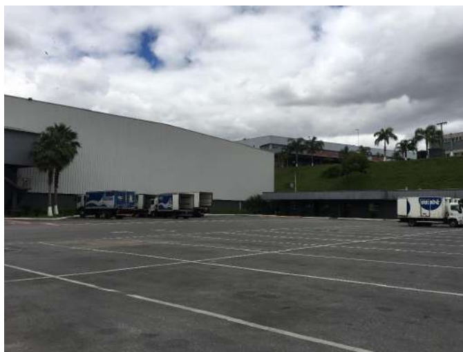
Área de estacionamento de caminhões
