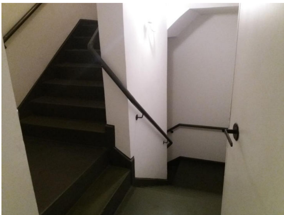
Escada de incêndio
