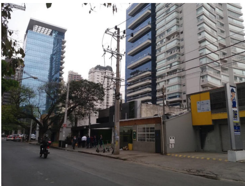
Rua Ramos Batista, com o imóvel à esquerda
